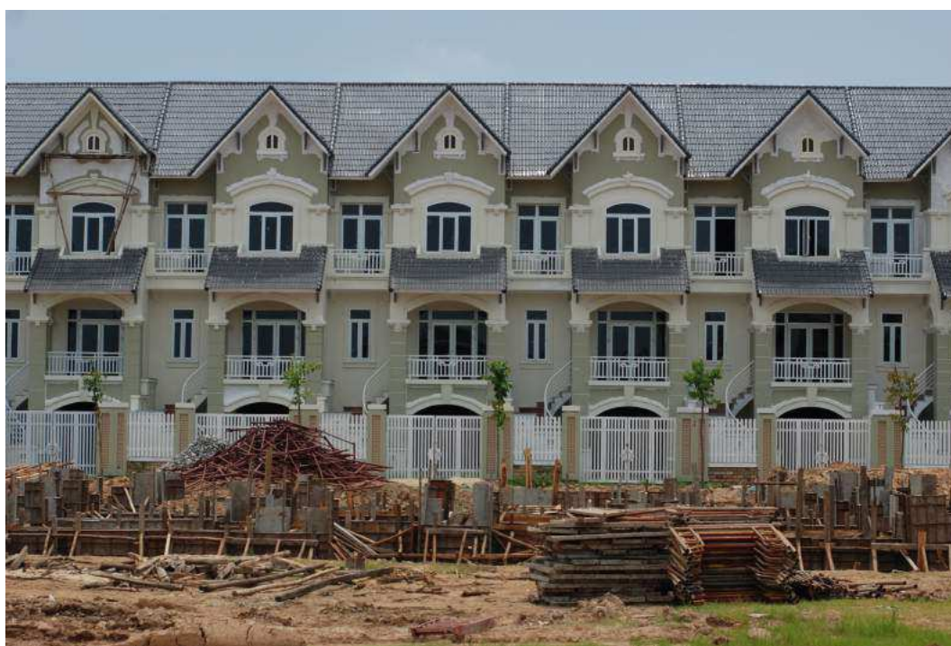
FIGURE 7.3: Nouveau quartier résidentiel en construction à An Khanh
