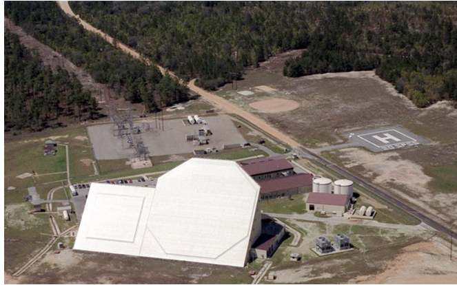
Figure 1.3 – Le FPS-85 est le premier radar à réseaux phasés dédié à la surveillance de l'espace. Il serait capable de détecter des objets d'un diamètre de 6 cm en orbite basse.
