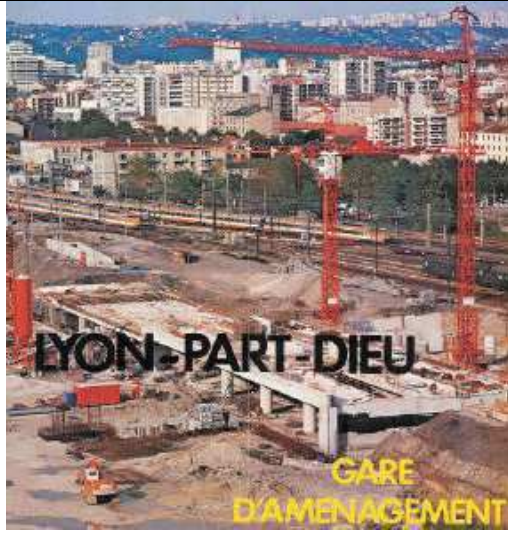
Photo n°147: La Nouvelle gare TGV de la Part-Dieu en construction
