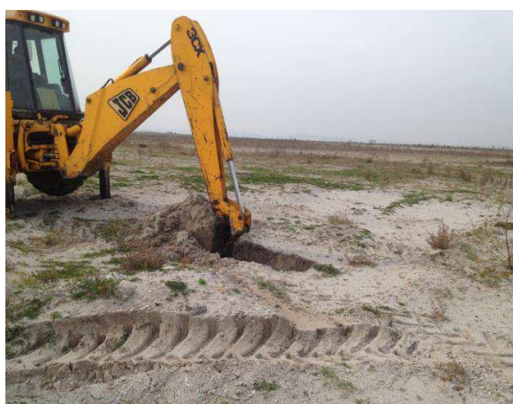
c. Extraction des sédiments à l'aide d'une pelle
