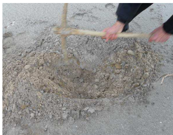
b. Exécution manuelle d'une fouille
