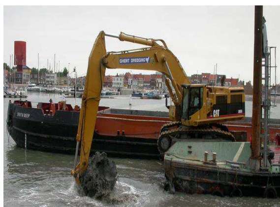
Photo 1. 6. Dragage à pelle rétro-excavatrice ( www.ghentdredging.be )
