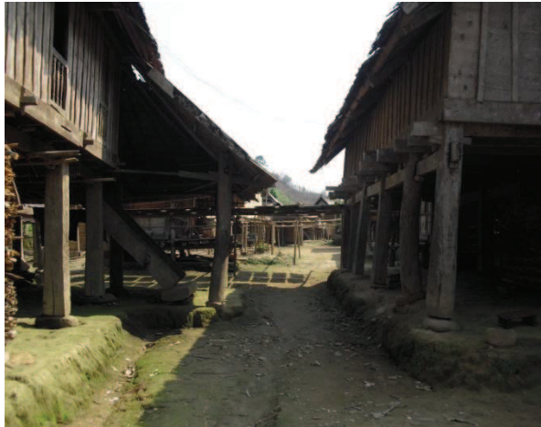
Dans le village de Punchong (Mueang Nam Bak), on peut voir que l'ensemble des maisons sur pilotis sont posées sur des pierres.
