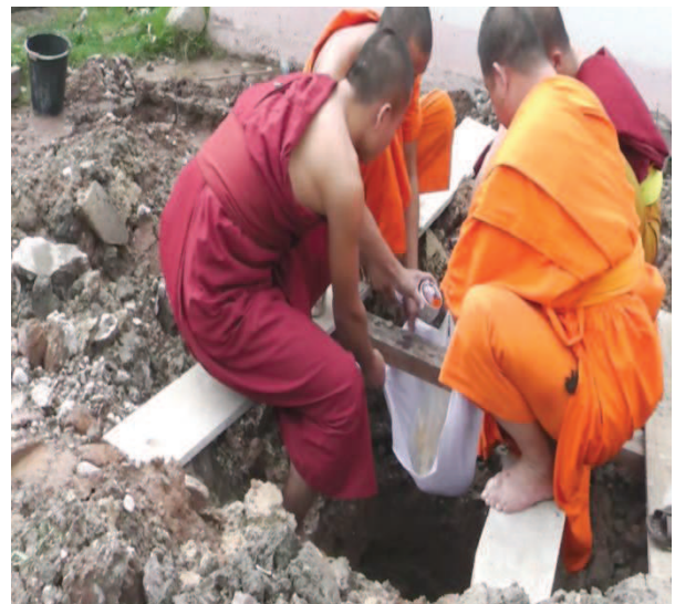
Dans la cour du vat , ils installent la pierre ainsi que les dons faits par les laïcs dans le trou au centre de la fondation du ho kong .
