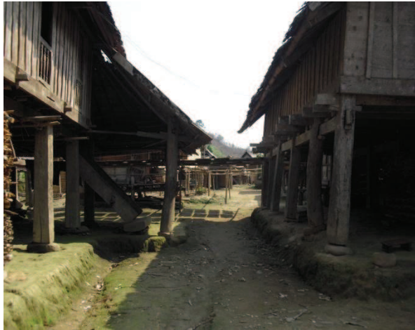
Dans le village de Punchong (Mueang Nam Bak), on peut voir que l'ensemble des maisons sur pilotis sont posées sur des pierres.
