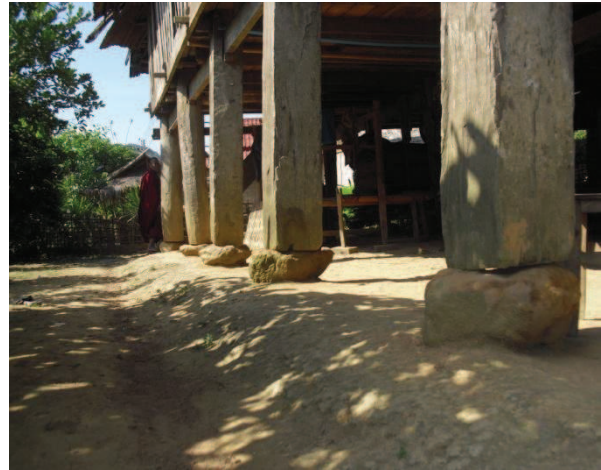
Mak hin (pierres) supportant les poteaux de la maison (Ban Namai).
