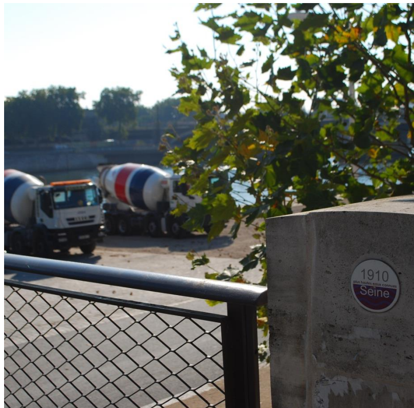
Photo 4 : Repère de crue sur le mur anticrue du quai Panhard et Levassor
