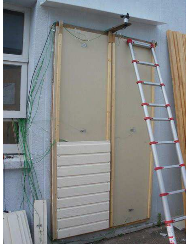
Figure 2.4 : Liteaux fixés, mise en place du bardage pin brut-clair
