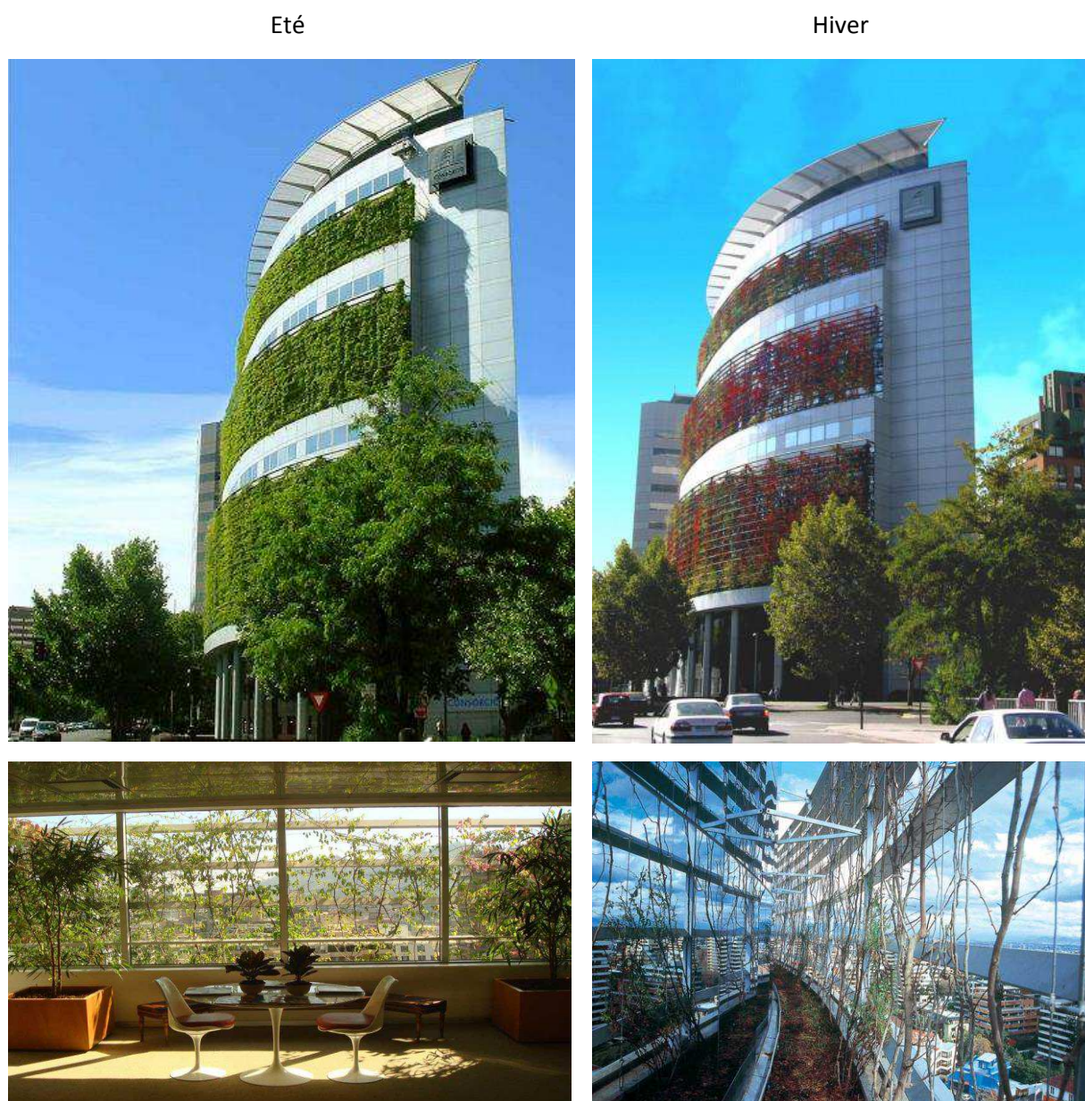
Figure 1.7 : Bâtiment Consorcio à Santiago au Chili avec une façade végétalisée, de l'architecte Enrique Brown. Vue extérieure et intérieure pour les saisons été et hiver.
