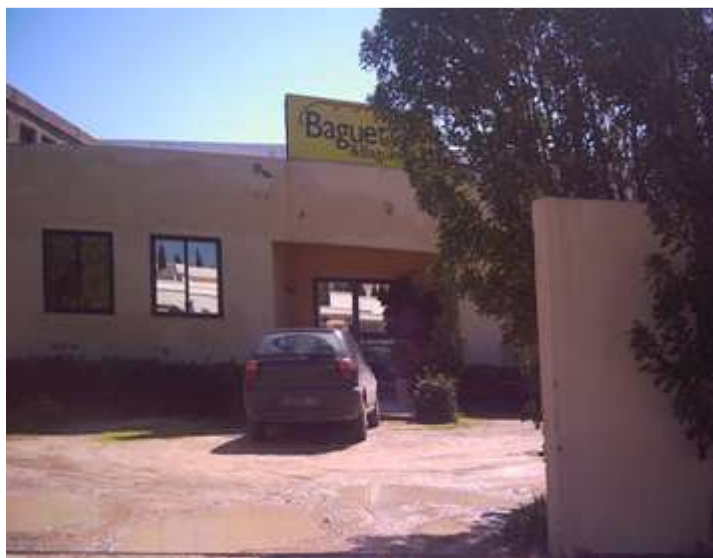
Source : SOUSSI R., visite de la zone industrielle Ariana Aéroport, 2011.
