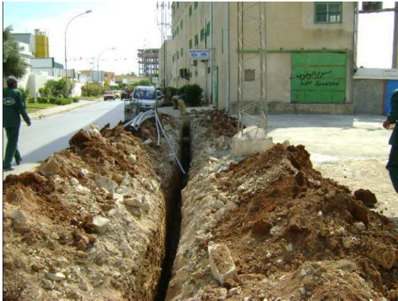
Photographie 31: Travaux d'installation de fibres optiques dans la zone industrielle de Ksar Saïd en 2009
