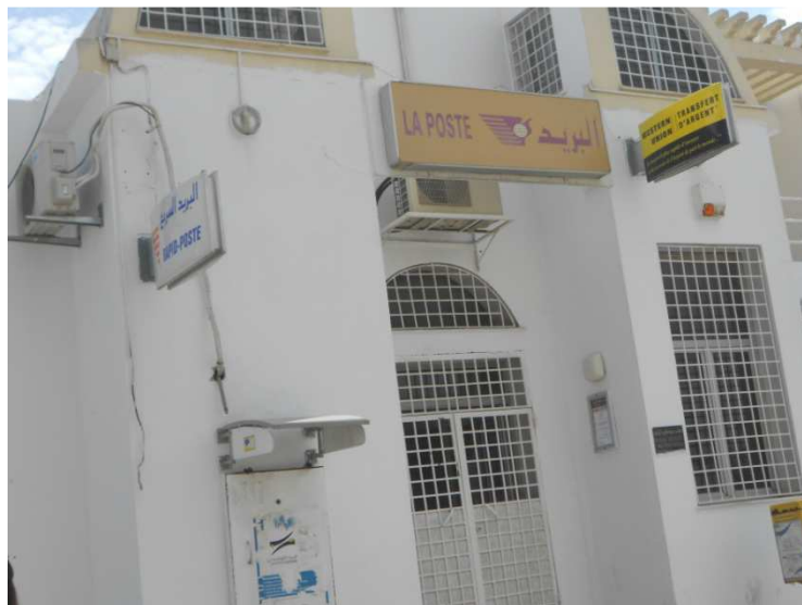
Source : SOUSSI R., visite de la zone industrielle Mégrine Z4, 2012
