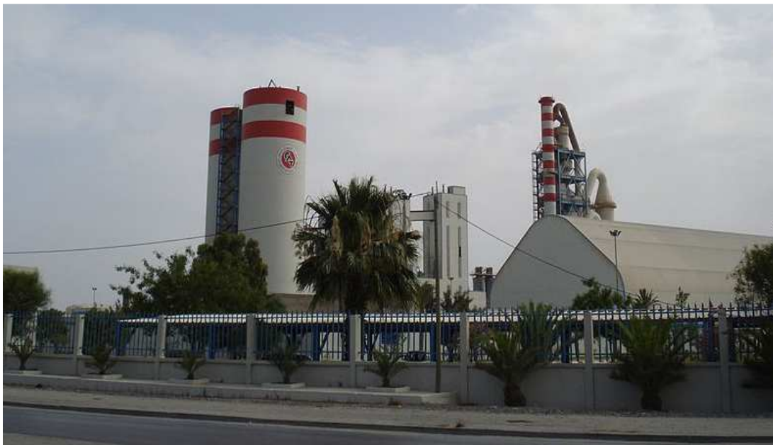
Photographie 1: Les Ciments Artificiels Tunisiens-Colacem zone industrielle Jebel Jelloud,2010
