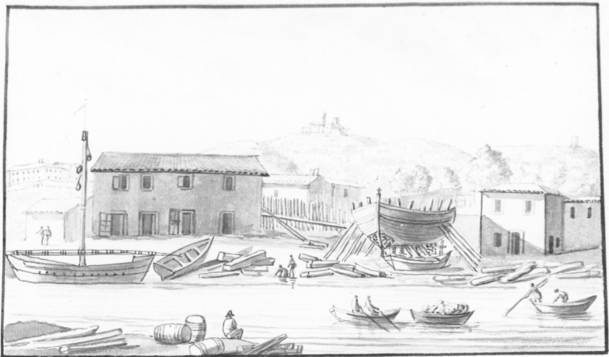
Doc. 118. Chantier de Ferrières. Gravure de Louis Mille, vers 1825 (musée Ziem).
