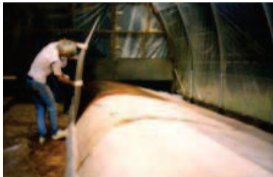
FIGURE 1.11 – Réalisation d'une coque en contreplaqué moulé - étape de pose des plis de bois [18]
