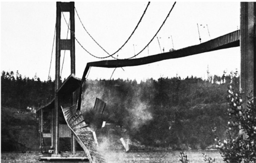
Figure FR-1.1. Effondrement du pont de Tacoma Narrows du fait des vibrations induites par les rafales de vent [1].
