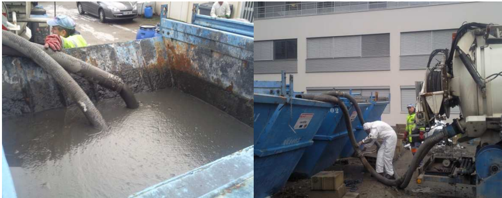
Figure III-11 : Principe de l'homogénéisation du sédiment
