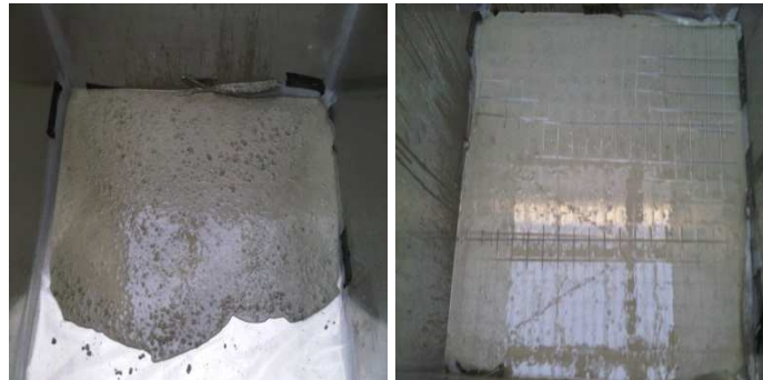
Figure V-11 : Placement de la couche du béton armé
