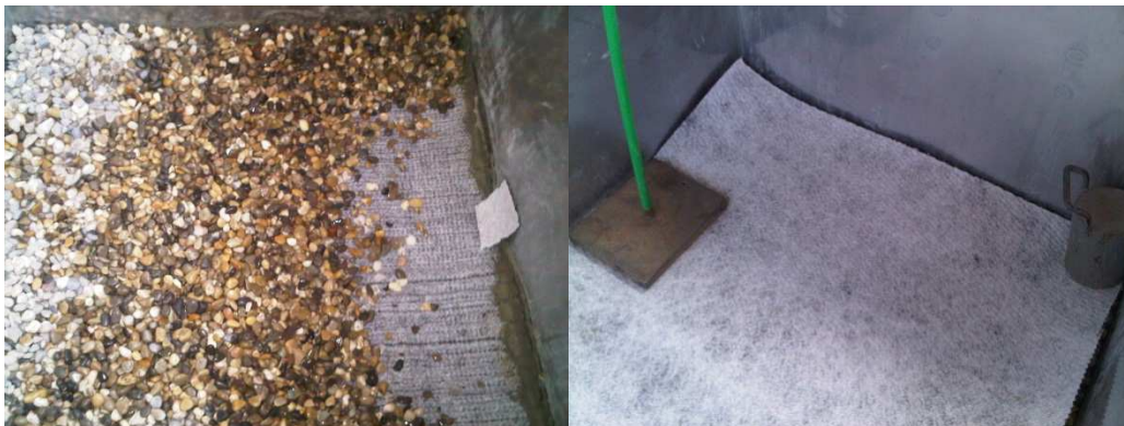
Figure V-15 : Couche drainante et au-dessus le géotextile de filtration
