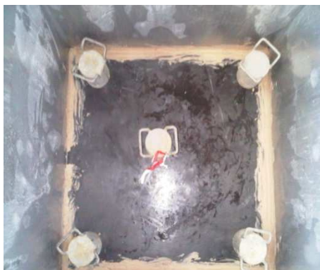
Figure V-12 : La géomembrane au fond du pilote, avec étanchéité latérale assurée par la bentonite
