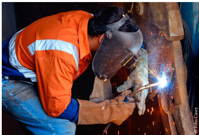
Figure I.1 : Réalisation d'une soudure en semi-automatique.
