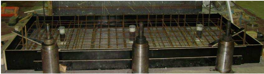
Fig. 2.7. Coffrage et ferrailage de la dalle rectangulaire de support.
