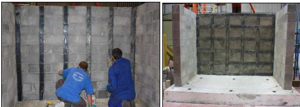
Fig. 2.24. Renforcement horizontal et vertical du quatrième mur.
