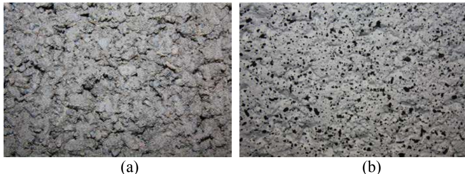
Fig. 2.30. La surface du mur, avant et après traitement par la spray-peinture.
