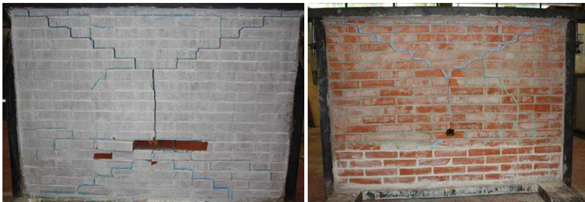
Fig. 4.134. Modes de rupture de la face avale et amont du mur après impact ( \theta=60^\circ ).
