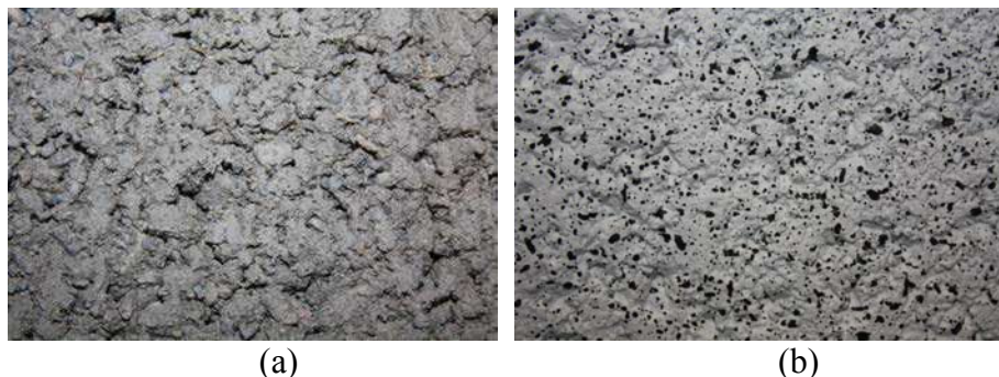
Fig. 2.30. La surface du mur, avant et après traitement par la spray-peinture.
