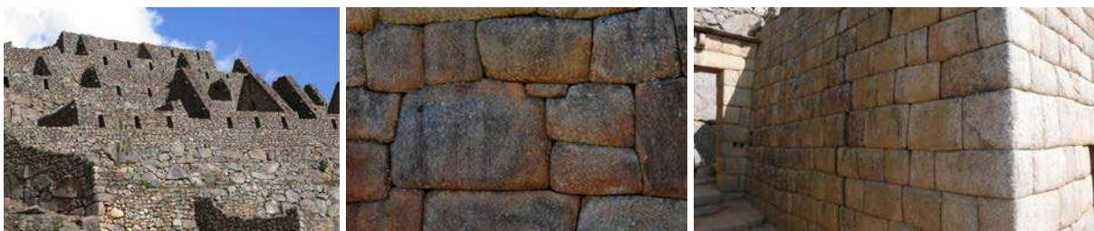
Fig. 4.118. Maçonnerie en pierres des joints secs à Pérou.
