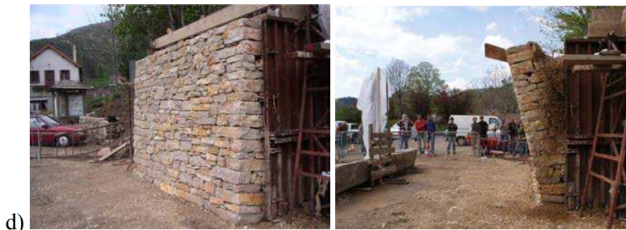
d) Fig. 1.1. Endommagement de murs maçonnés : a) explosion gaz [THO 1971] ; b) impact voiture : Cambridge, Angleterre, décembre 2001 [KEL 2003] ; c) inondation : Malton, Angleterre, novembre 2000 [KEL 2003] ; d) pression de sol sur un mur de soutènement en pierre sèche [COL 2009].
