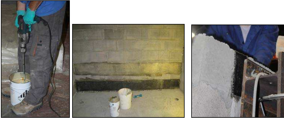
Fig. 2.22.a) Mélange de résine ; b) Pose d'une bande TFC horizontale ; c) Recouvrement de 20cm à l'arrière du mur principal pour ancrage de la bande
