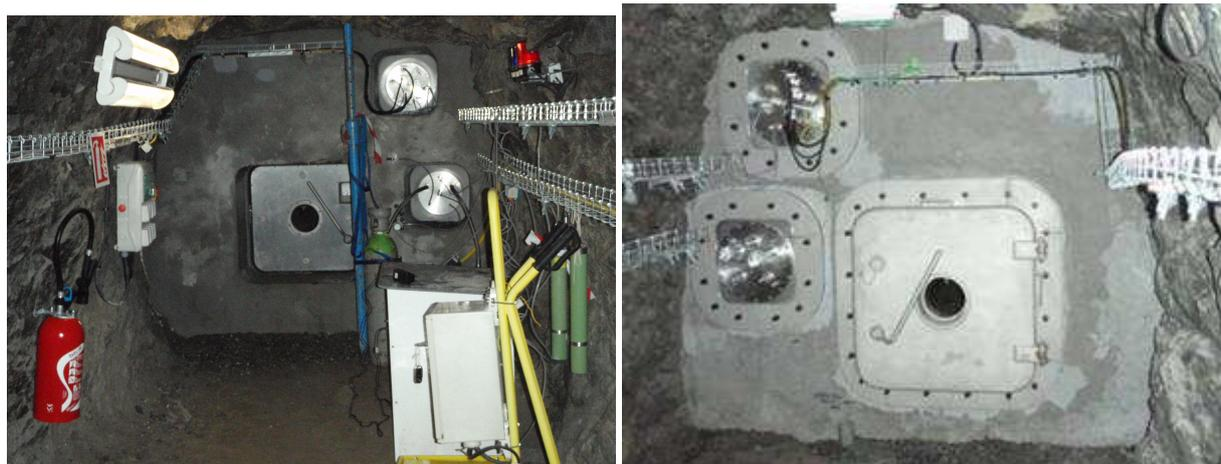
**FIGURE 1.12** – Photos du mur étanche délimitant la chambre isolée C, 20 m avant le fond du tunnel. La photo de droite est prise depuis l'intérieur de la chambre. Une porte étanche permet de rentrer dans la chambre. Deux platines permettent le passage des connexions électriques (en haut) et des fluides (en bas).
