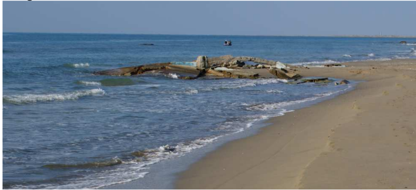
Figure 127: Régression d'une plage sur la flèche enfermant la lagune de Narta. Un équipement communiste a été détruit par les eaux ; remarquer au premier plan la micro-falaise typique d'une situation de régression après une progression. Cliché A.Shallari (novembre 2011).
