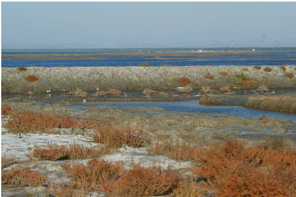
Figure 82 : Ancienne digue entre la lagune et d'anciennes terres cultivées, aujourd'hui salinisées. Sur la carte : n°5. Cliché A. Shallari © , Novembre 2011,
