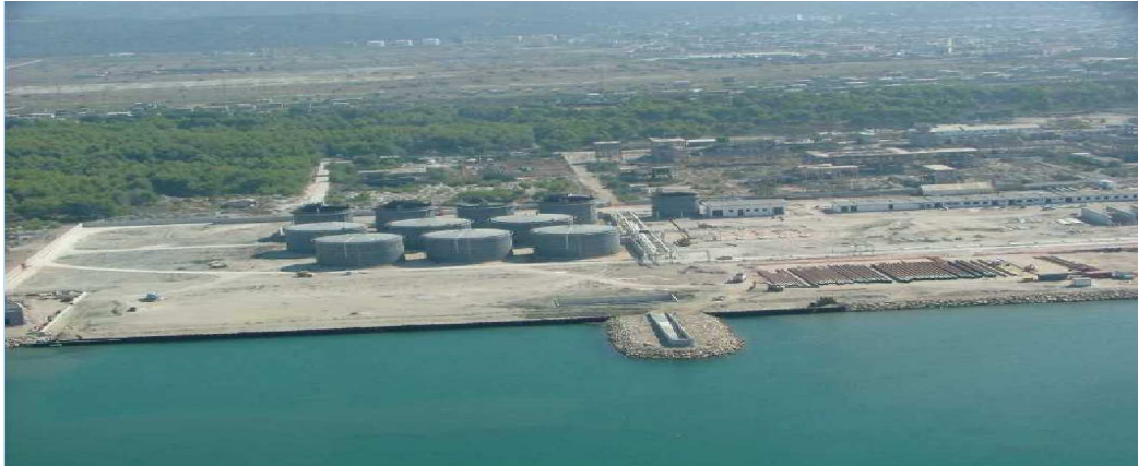
Figure 125 : Le terminal pétrolier de Vlora, au Nord de la ville, en construction (2011). Le terminal est aujourd'hui achevé, mais le transfert du pétrole vers les cuves de stockage se fait par camion, car l'oléoduc AMBO n'est pas encore achevé.
