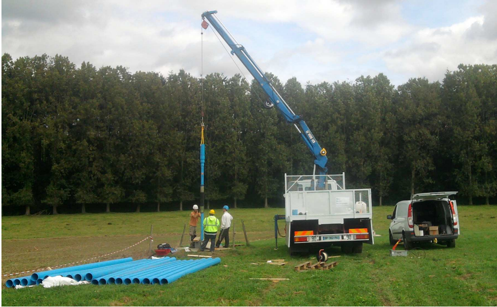
FIGURE 2.2 – Installation du packer sur le forage F3 à 80 m de profondeur par la société GHI SA (Géo Hydro Investigation).
