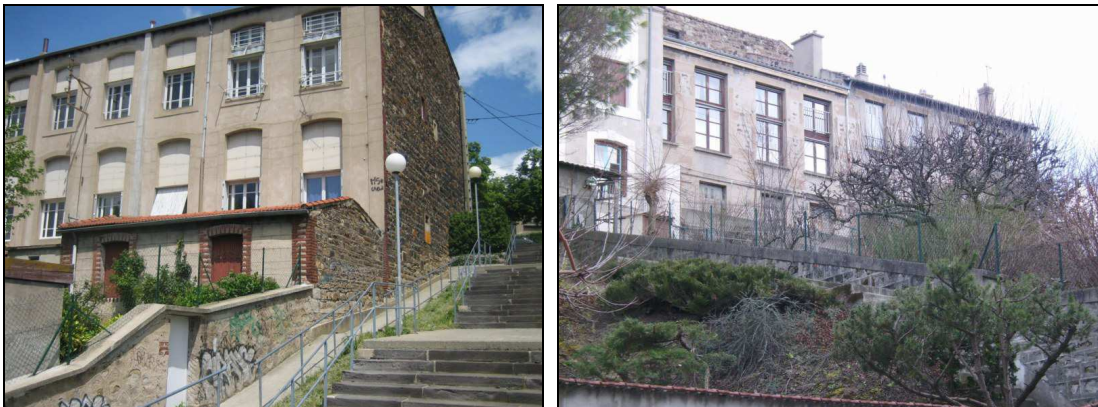
Images 11 et 12 : Immeubles de passementiers à la Vivaraize et au Crêt-de-Roc (Saint-Etienne).
