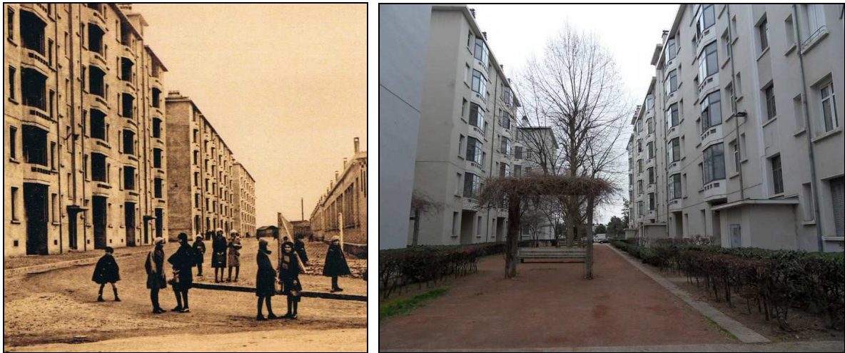
Images 154 et 155 : Rythme des façades avant et après travaux, cité Tony-Garnier.
