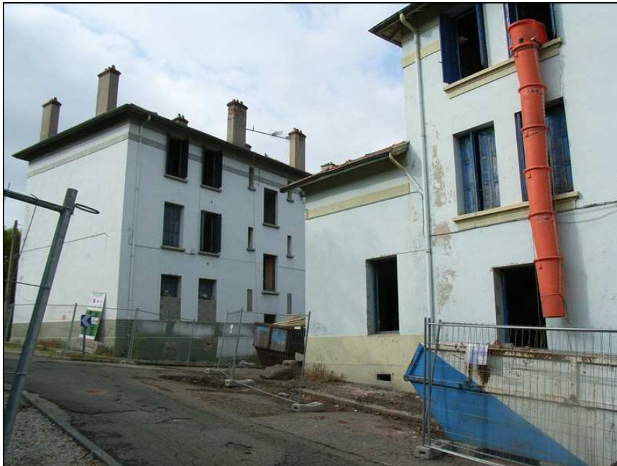
Image 165 : L'Ancienne cité de la Romière en travaux.
