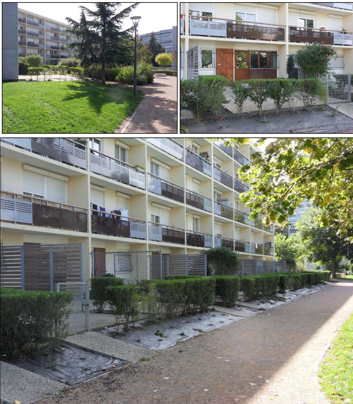
Images 53 à 55 : Le GE de la Palle résidentialisé.
