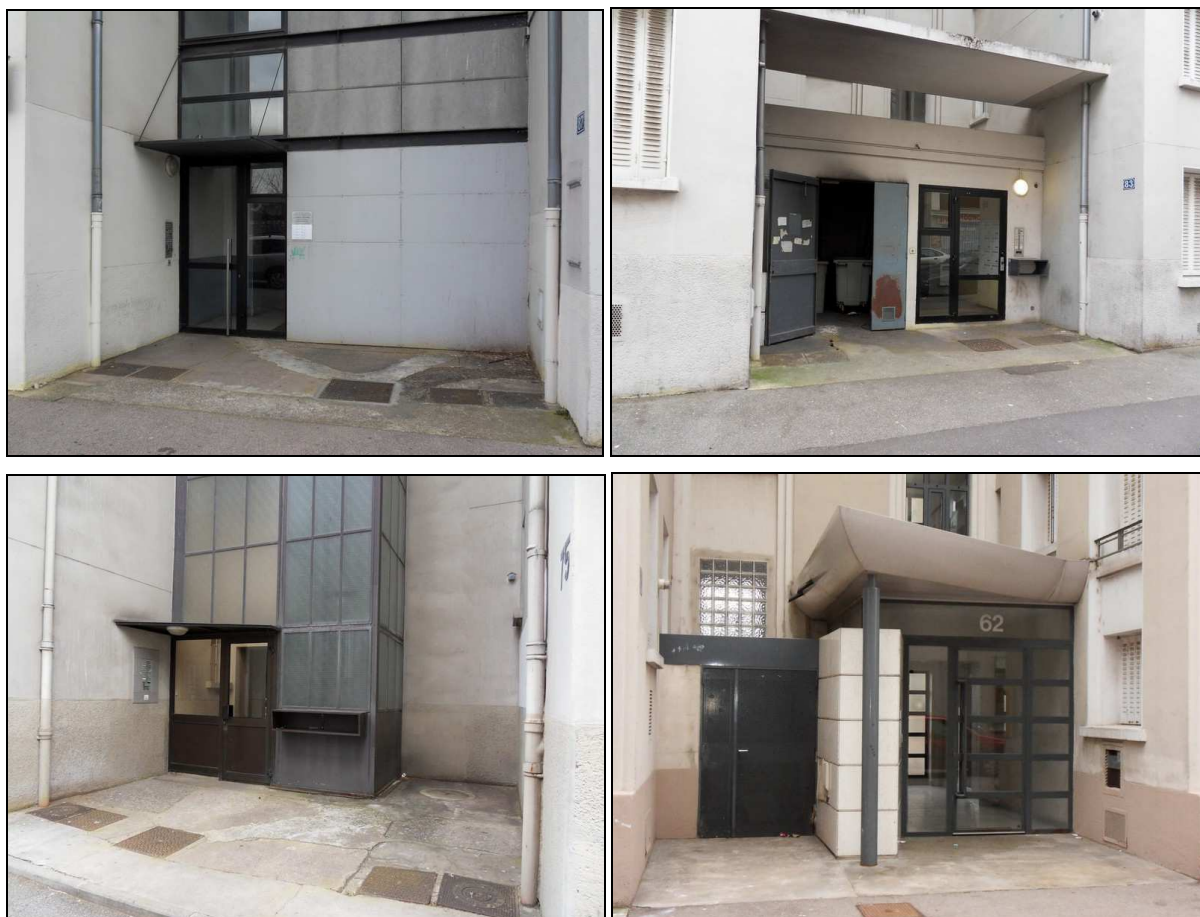
Images 156 à 159 : Entrées d'immeubles, cité Tony-Garnier.
