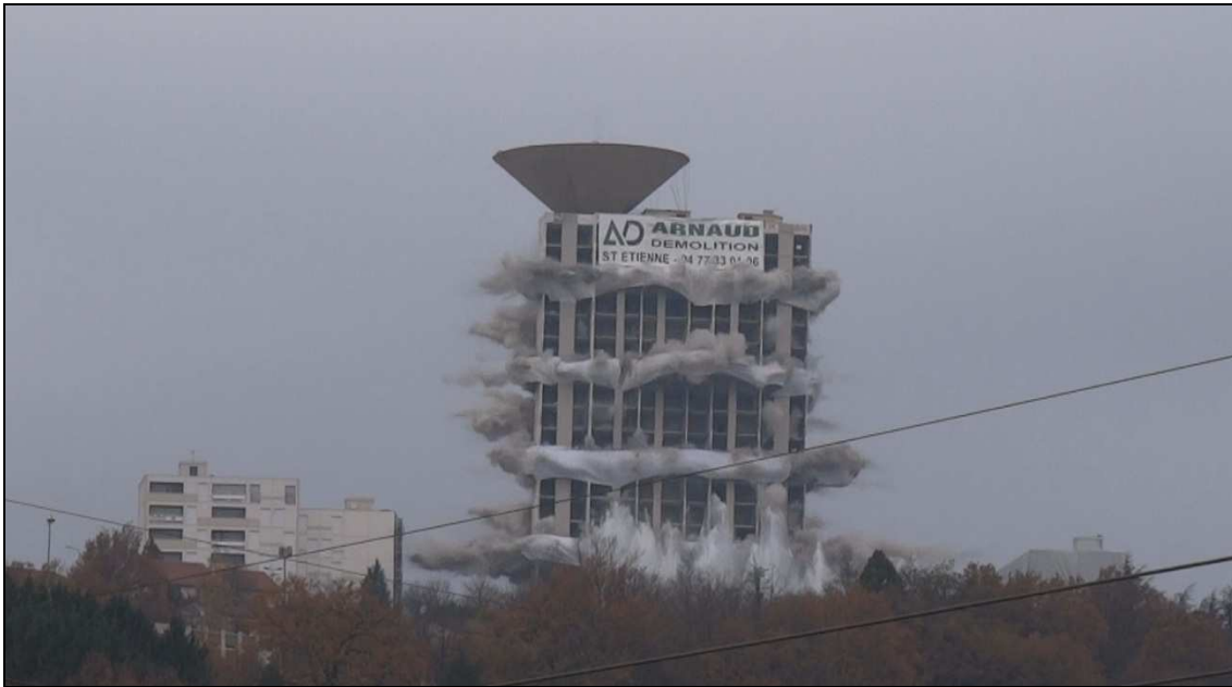
Image 136 : Démolition de la tour Plein ciel, 24 novembre 2011.
