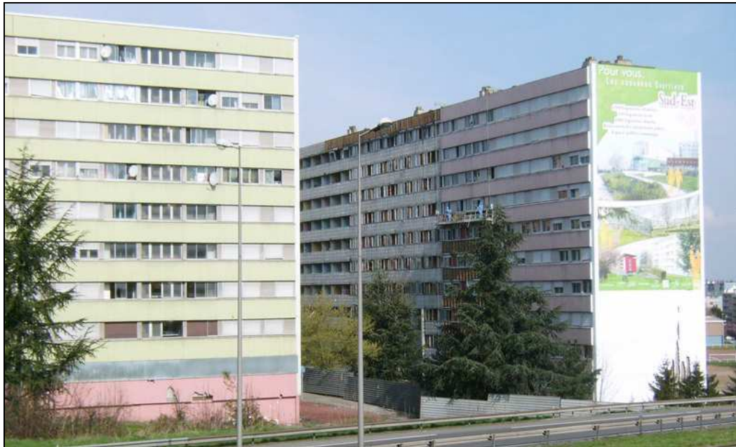
Image 9 : Immeubles voués à démolition à Montchovet.
