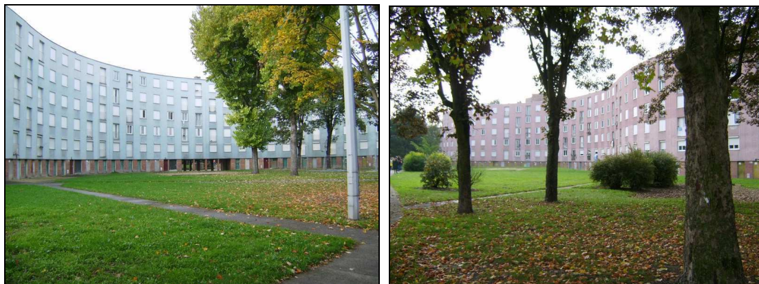
Images 166 et 167 : Le Serpentin d'Emile Aillaud (Pantin). Façades intérieure et extérieure. R. Kaddour, octobre 2007.
