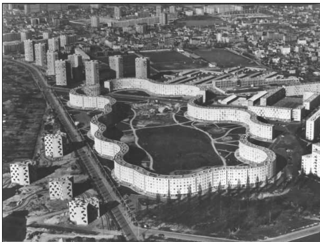
Image 168 : Le Serpentin d'Emile Aillaud (Pantin). DAF - CAP/Centre d'archives d'architecture du XX e siècle.
