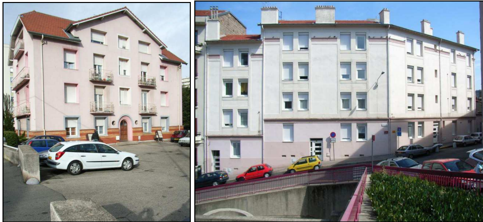
Images 15 et 16 : HBM de l'office départemental à la Richelandière (1939) et au Mont-d'Or (1932) à Saint-Etienne.
