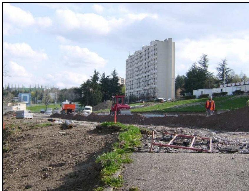
Image 6 : La Grande Marandinière en chantier.
