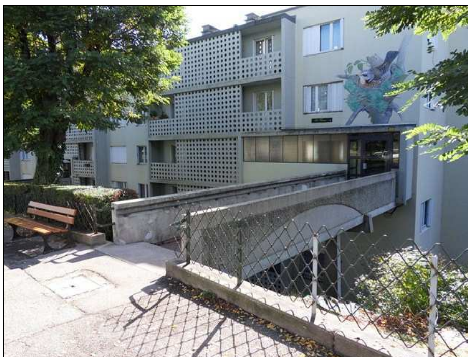
Image 102 : Passerelles de 2000, rue Le-Corbusier (Beaulieu). R. Kaddour , octobre 2010 .
