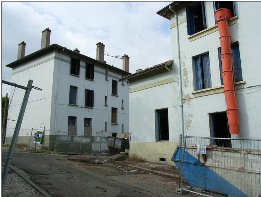
Image 165 : L'Ancienne cité de la Romière en travaux.
