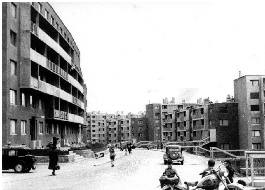
Image 101 : Passerelles d'origine, rue Le-Corbusier (Beaulieu). Années 1950 (collection privée).
