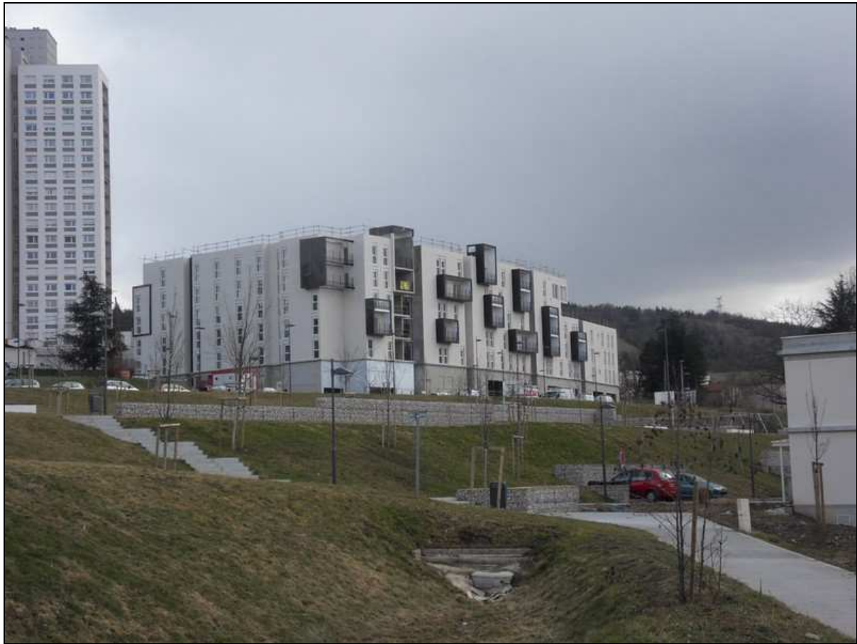
Image 120 : La Grande Marandinière en reconstruction : vue d'ensemble de la première tranche.
