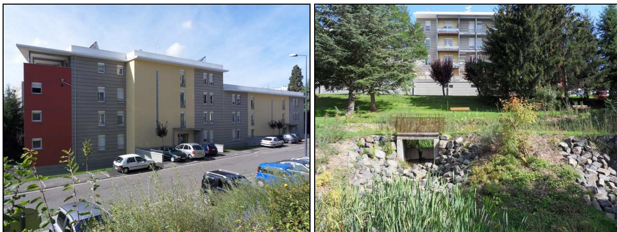
Images 46 et 47 : Immeuble « le Pont-Aven », avec bassins de récupération des eaux de pluie, La Palle (Saint-Etienne).
