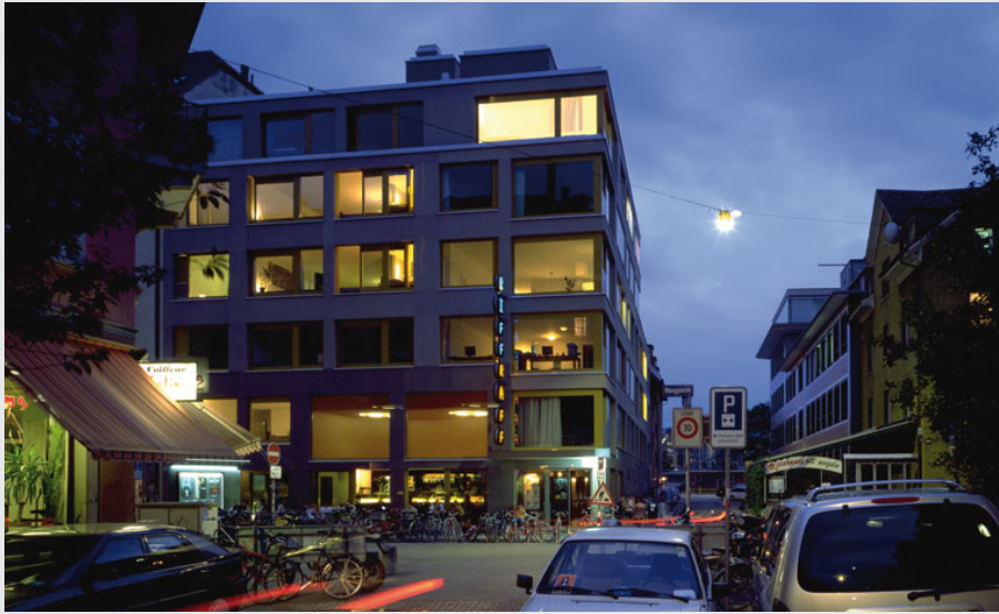
Fig.290 Immeuble de logements pour cohabitants à Zürich, photo : Heinrich Helfenstein ( http://www.af-z.ch/presse/meilipeter )
