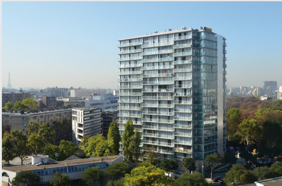
FIG.231 Réhabilitation de la tour de Bois-le-Prêtre, photo : Druot, Lacaton & Vassal (DRUOT, LACATON, ET VASSAL, 2007)
