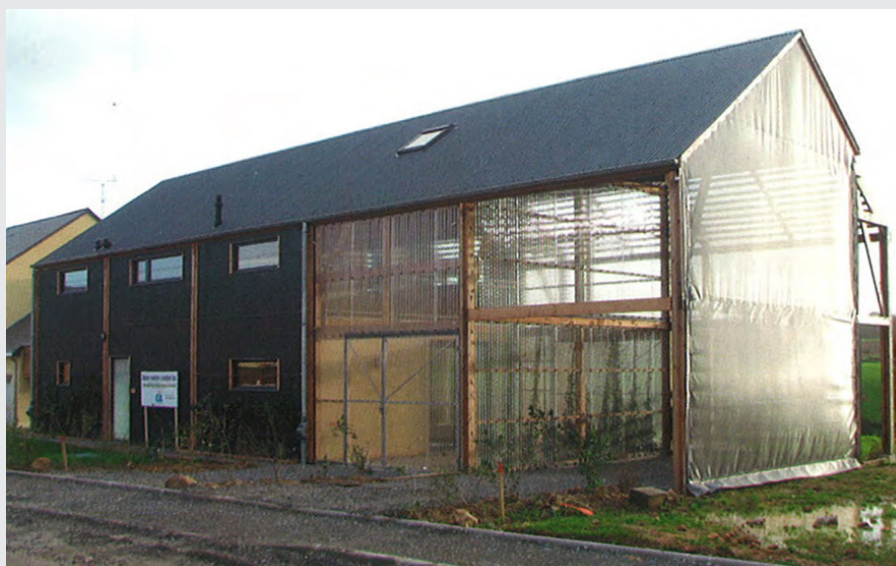
FIG.276 Maison de constructeur évolutive, architectes : C. Gaudoin, A. Morin, photo : CIL 53 (DARMON, 2007, p.18)
