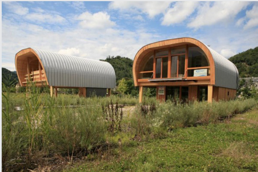
Fig.274 Premières réalisations du « lotissement des coccinelles », architectes : G Studio, photo : G Studio (DER MADIROSSIAN, VAUTRIN, CERTU, ET AL., 2011, p.73)
