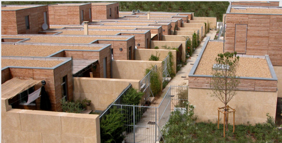
Fig.272 Les Villas Vanille, Cusy-Maraval architectes (VILLAS VANILLE)
