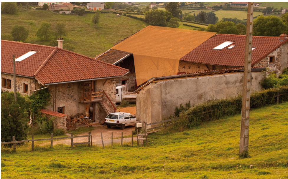
Fig.296 Habitat groupé avec grange commune à Saint-Pierre-le-Vieux (CLOQUET, 2012)
