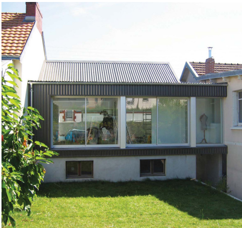
Fig.209 Exemple de construction d'un nouveau logement à l'alignement (BIMBY)
