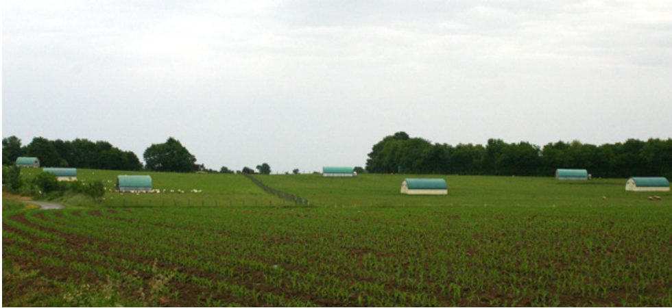
Fig.244 Bâtiments à volailles, photo : Fabriques (NOUVELLES FRICHES BÂTIES AGRICOLES)
