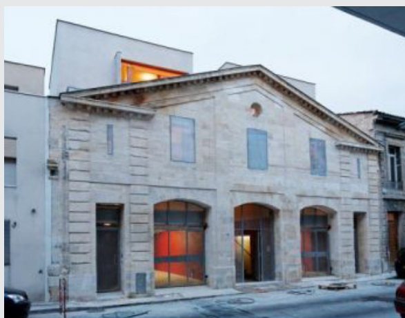
Fig.252 Façade de l'ancien entrepôt conservée, architecte : Bernard Bühler, photos : Vincent Monthiers (RÉHABILITATION D'UN ENTREPÔT EN 20 LOGEMENTS À BORDEAUX)
