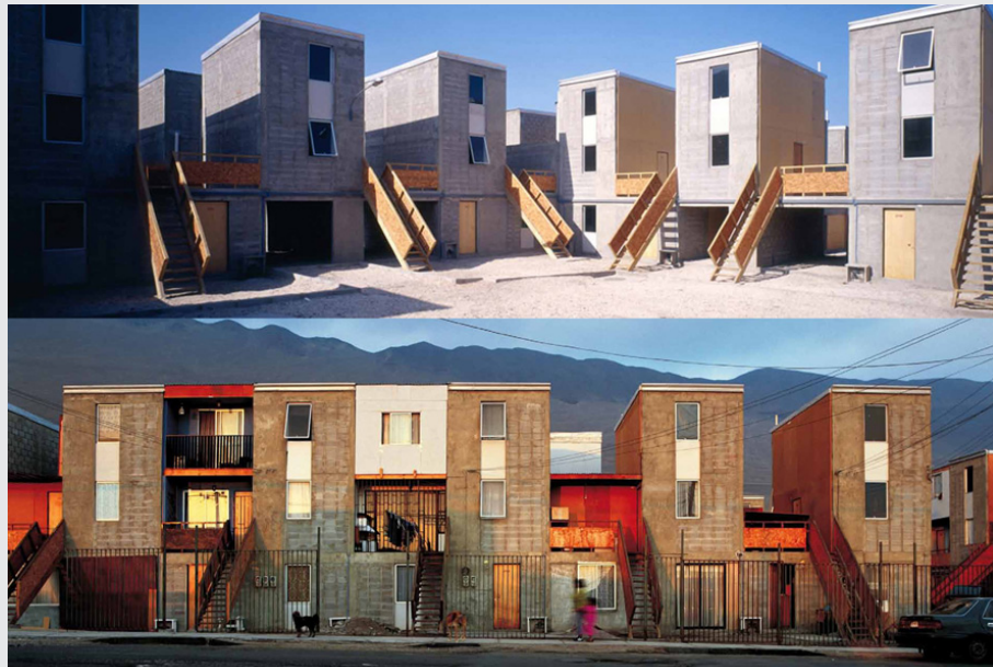
Fig.271 Quinta Monroy avant et après modifications par les habitants, photos : Elemental, Tomas Cortese (QUINTA MONROY)
