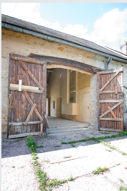
Fig.242 Grange aménagée vue de l'extérieur, photo : Atelier Correia et associés (AMÉNAGEMENT D'UNE GRANGE)
