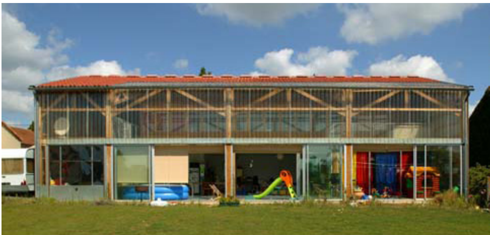
Fig.259 Maison dans le hangar , architectes : Gasté & Bazantay, photo : S. Chalmeau (DARMON, 2006, p.114)
