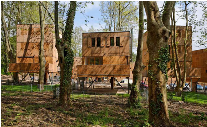
Fig.216 39 logements sociaux, Bayonne, architecte : Bernard Bühler, photo : Vincent Monthiers (39 LOGEMENTS SOCIAUX OSSATURE BOIS À BAYONNE)
