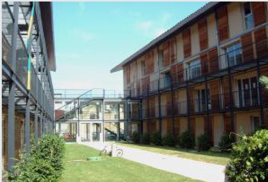
Fig.292 Résidence étudiante à Cluny, architectes : Tectoniques, photo : Dieter Hendel
