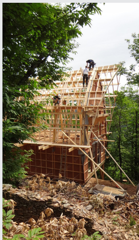
Fig.280 Les premières maisons en construction, photo : Construire (ENSEMBLE À BEAUMONT EN ARDÈCHE)
