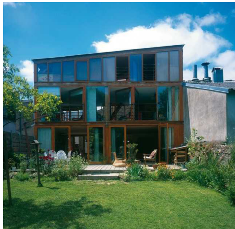
Fig.210 Exemple de construction d'un nouveau logement à l'alignement, architecte : X. Fouquet, photo : P. Ruault (DARMON, 2009, p.24)
