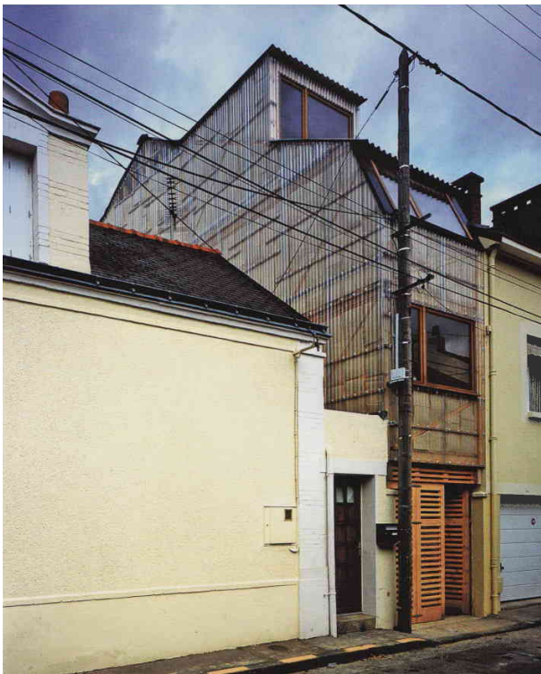
Fig.201 Extension de maison dans une dent creuse, architecte : Xavier Fouquet, photo : Philippe Ruault (DARMON, 2011, p.51)
