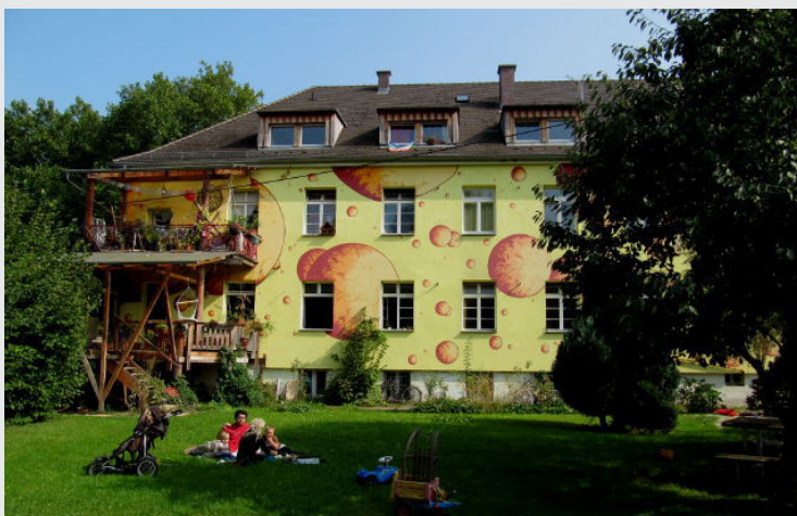
Fig.143 S.U.S.I. Ancienne caserne transformée en logements autoréhabilités en Allemagne, photo : Jens Schäfer, 2009 ( http://www.freiburg-schwarzwald.de/littenweiler/vauban.htm#Susi%20-%20Selbstorganisierte%20Unabh%C3%A4ngige%20SiedlungsInitiative )
