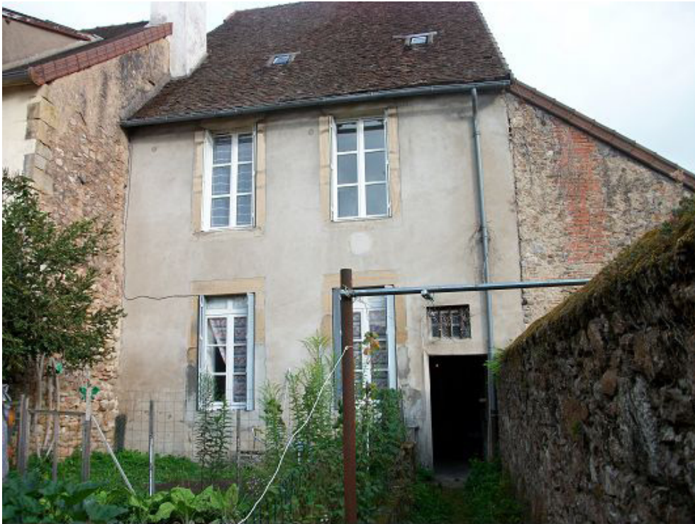
Fig.183 Maison de ville à Autun (photo : http://www.trouver-un-logement.com/annonce-immobiliere-autun-f49o.htm )
