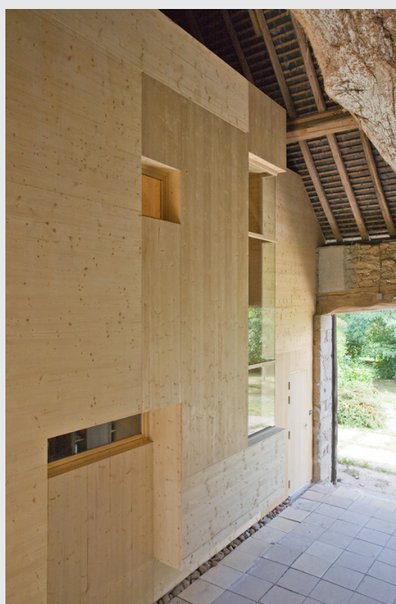
Fig.243 Grange aménagée vue de l'intérieur de la grange, photo : Atelier Correia et associés (AMÉNAGEMENT D'UNE GRANGE)
