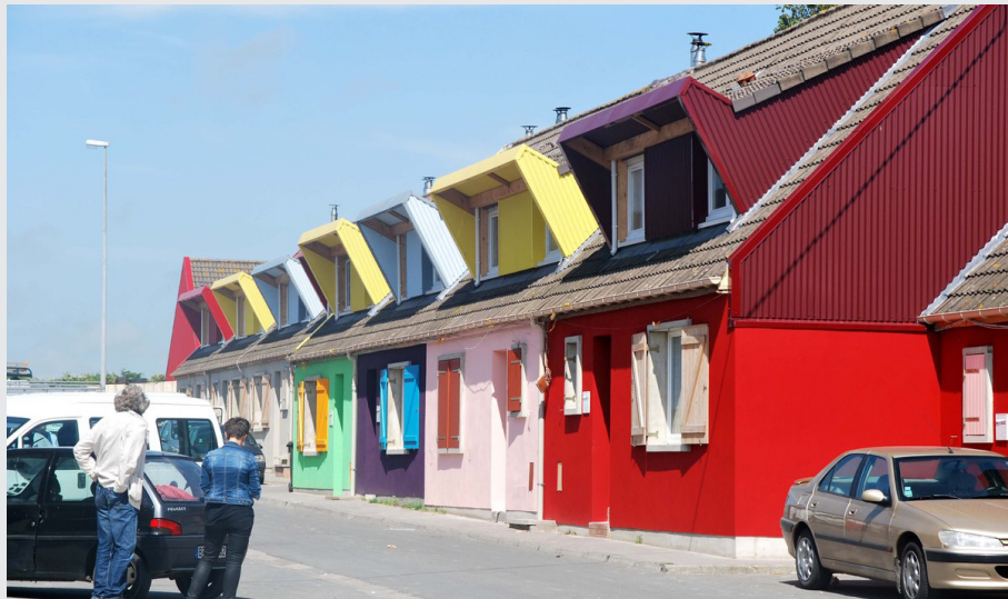
Fig.142 Les habitants des soixante maisons ont été invités à choisir les couleurs de leurs façades, Construire, 2012 (ENSEMBLE À BOULOGNE SUR MER)
