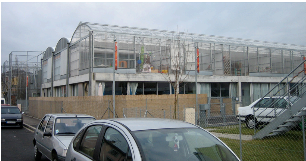
Fig.268 Cité Manifeste de Mulhouse : logements en bandes sur 2 niveaux, architectes : Lacaton & Vassal (CLOQUET, 2009)
