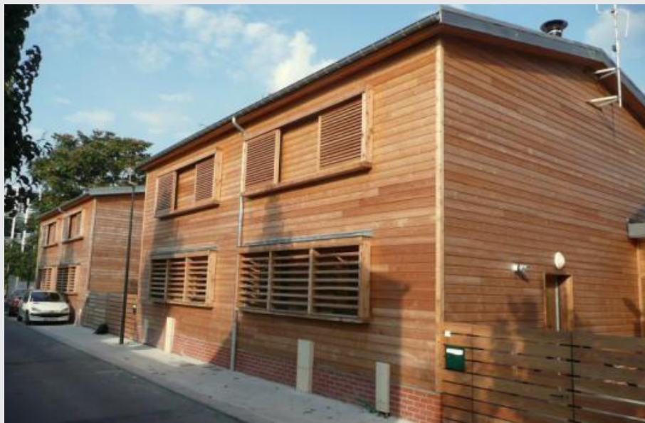
Fig.176 Maisons en accession sociale à Saint-Denis, photo : Le Chênelet Construction (QUATRE LOGEMENTS SOCIAUX À SAINT-DENIS)
