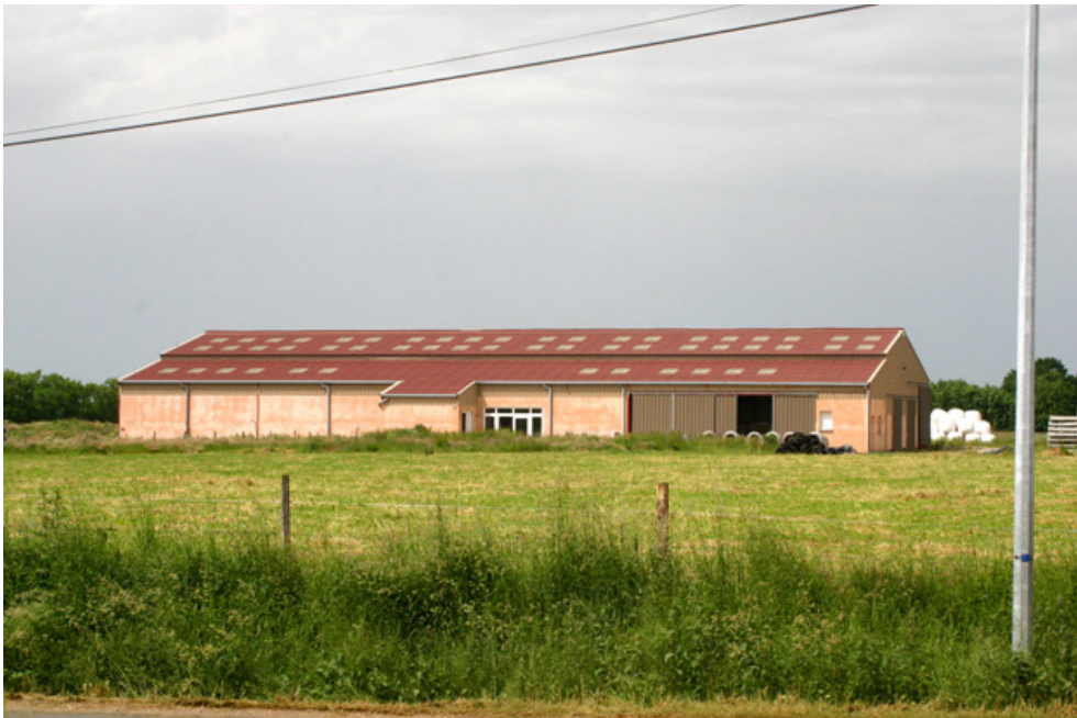
Fig.245 Étable en stabulation libre pour bovins laitiers, photo : Fabriques (NOUVELLES FRICHES BÂTIES AGRICOLES)
