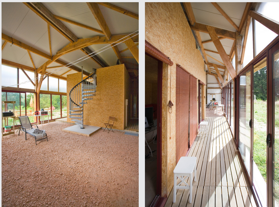
Fig.265 Intérieur de la maison sous un hangar en bois, photos : Atelier Correia Architectes et associés (RÉINTERPRÉTATION DU HANGAR AGRICOLE)
