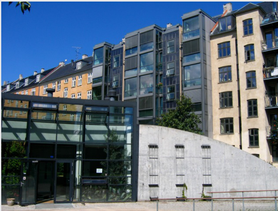
Fig.294 Maison commune de l'îlot d'Hedebygade, photo : Nathalie Ardon, 2009
