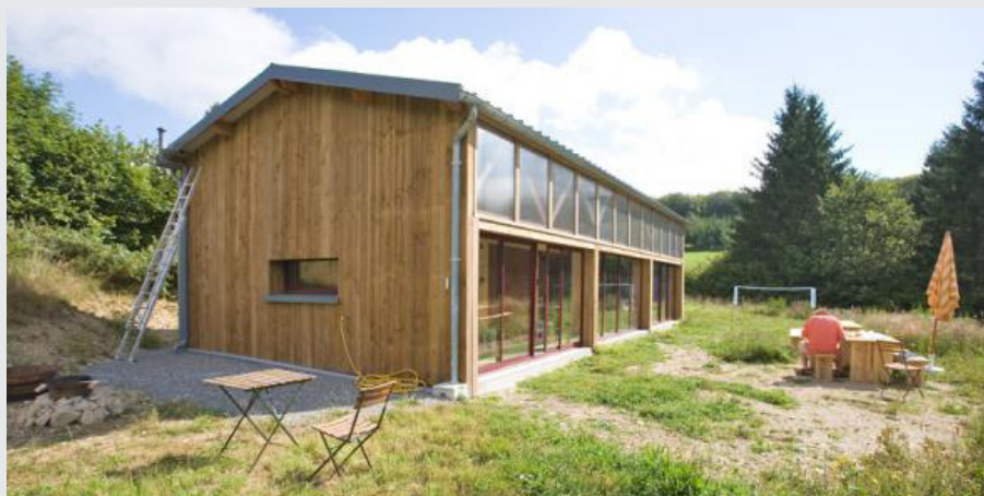
Fig.264 Maison sous un hangar en bois dans le Morvan, photo : Atelier Correia Architectes et associés (RÉINTERPRÉTATION DU HANGAR AGRICOLE)
