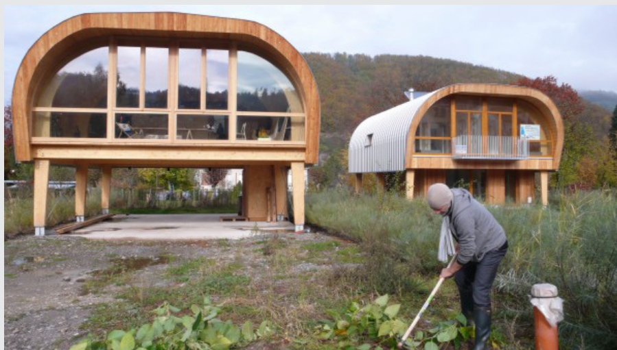
Fig.166 Lotissement des Coccinelles, Architectes : G Studio, photo : G Studio (LOTISSEMENT ÉCOLOGIQUE, SAINTE-CROIX-AUX-MINES)
