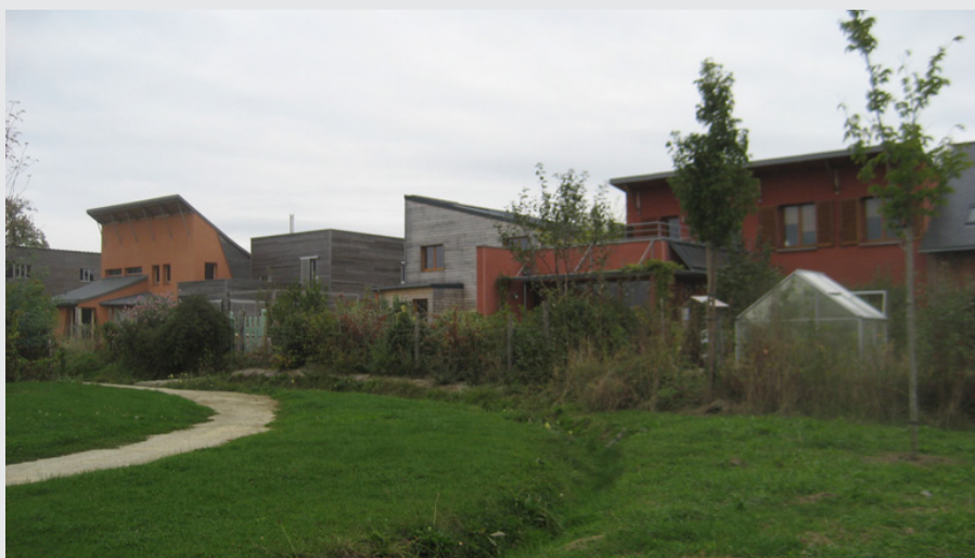
Fig.119 Nouveau lotissement à Hédé-Bazouges (CLOQUET, 2009)
