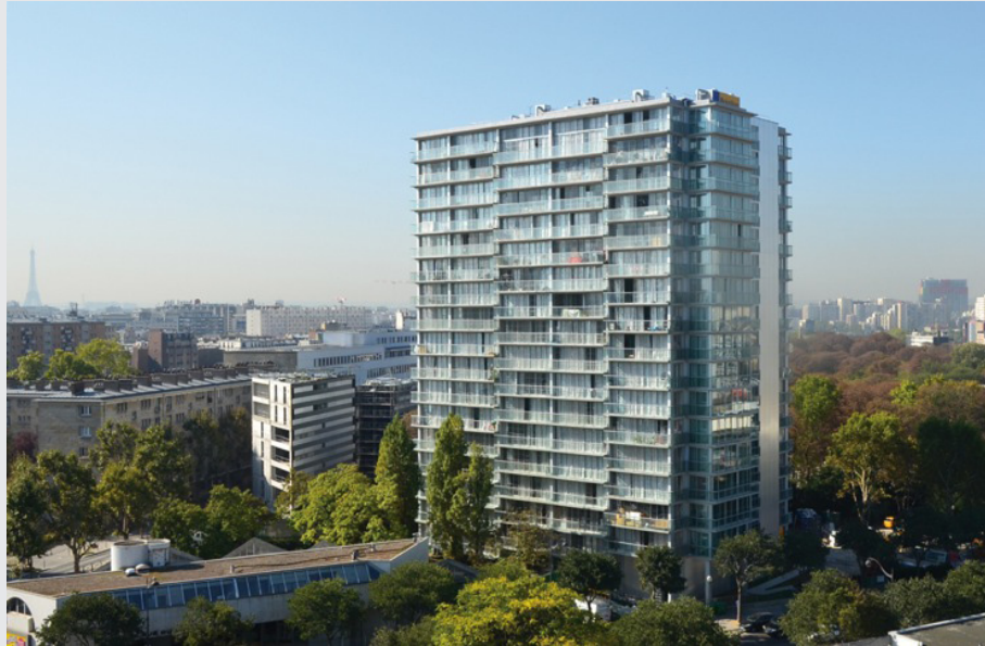
FIG.231 Réhabilitation de la tour de Bois-le-Prêtre, photo : Druot, Lacaton & Vassal (DRUOT, LACATON, ET VASSAL, 2007)
