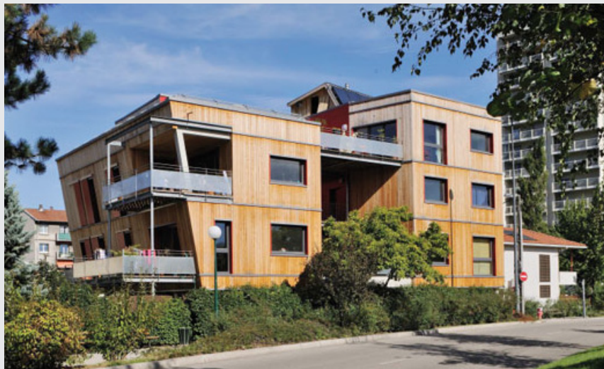
Fig.145 La Salière, Grenoble, architectes : Tekhnê, photo : Studio E. Salliet (WILSON ET POUSSE, 2011, p.68)
