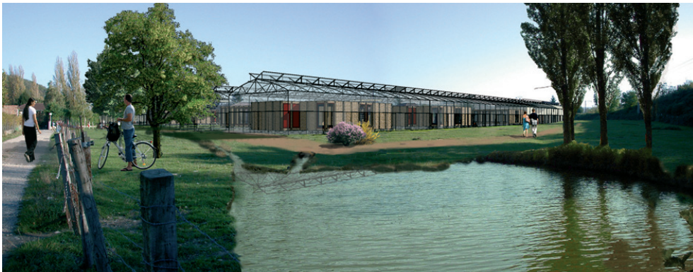
Fig.267 Projet de fin d'études « Entre serre et terre » : maisons en bande (BOIS-SOULIER, CHAMODOT, ET CLOQUET, 2006)
