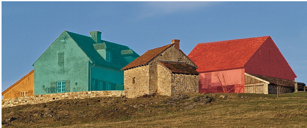
Fig.189 Ferme dans le charolais (montage réalisé d'après une photo issue de http://www.fotocommunity.fr )
