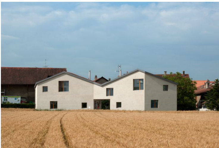
FIG.217 Maisons mitoyennes, LRS architectes, photo : T. Jantscher (MAISONS D'HABITATION MITOYENNES)
