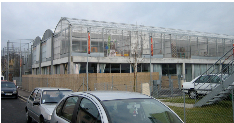
Fig.268 Cité Manifeste de Mulhouse : logements en bandes sur 2 niveaux, architectes : Lacaton & Vassal (CLOQUET, 2009)
