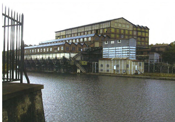
Fig.85 Lavoire de Chavannes, Montceau-les-mines (IDEM, P.194)
