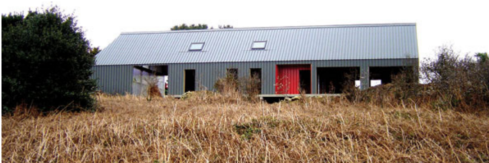
Fig.260 Hangar-maison, architecte : Catherine Rannou, photo : C. Rannou ( http://www.otua.org/formation/maison-contemporaine-2006/nord-ouest.htm )
