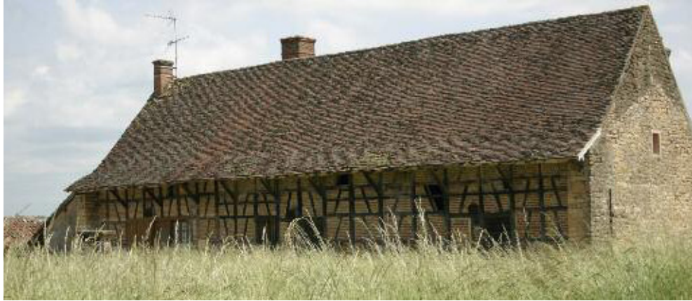
Fig.240 Grange en Bresse (CAUE 71, 2001b)
