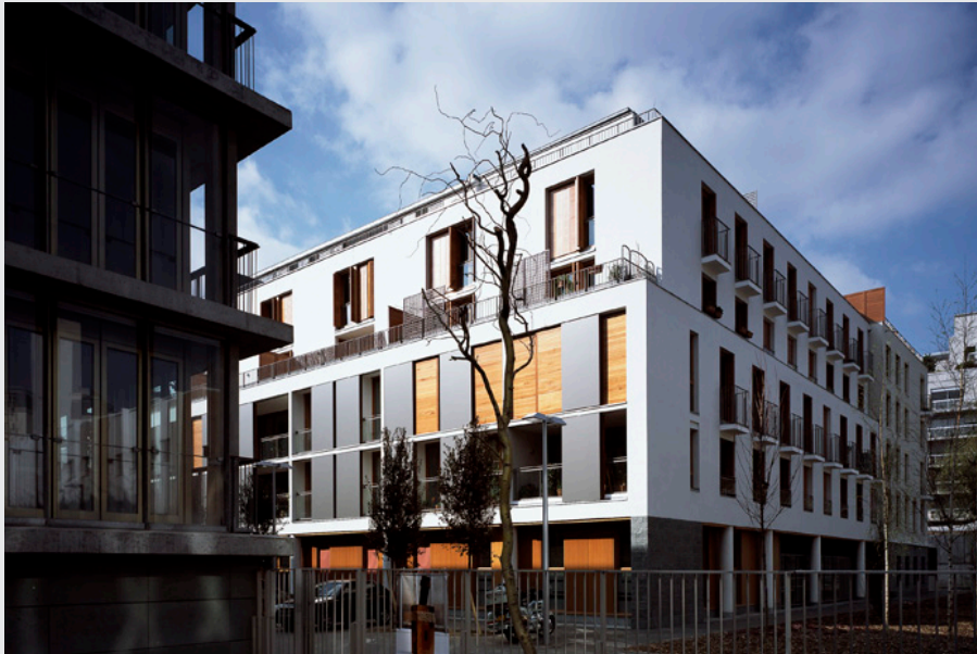
Fig.283 Immeuble de logements pouvant être couplés à Paris, photo : Badia-Berger architectes (PARIS, CARRÉ PHILDOR)
