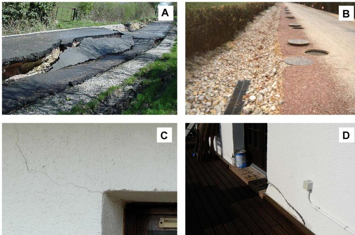
(A) état de la route en mai 2001 suite au déclenchement du glissement à *Lécaude* (TP-Géo, 2001) ; (B) restauration de la route, remblai de l’escarpement principal et pose de drains siphon (TP-Géo, 2002) ; (C) et (D) illustrations de la fissuration progressive de l’habitation directement exposée au glissement (mars 2010)
