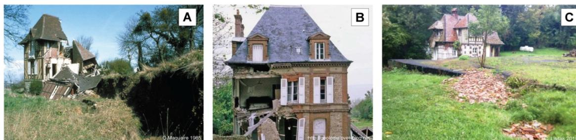
(A) et (B), dégâts structurels sur le bâti suite aux événements de 1982 et (C), fracture ouverte apparue suite à la réactivation de 2001.
