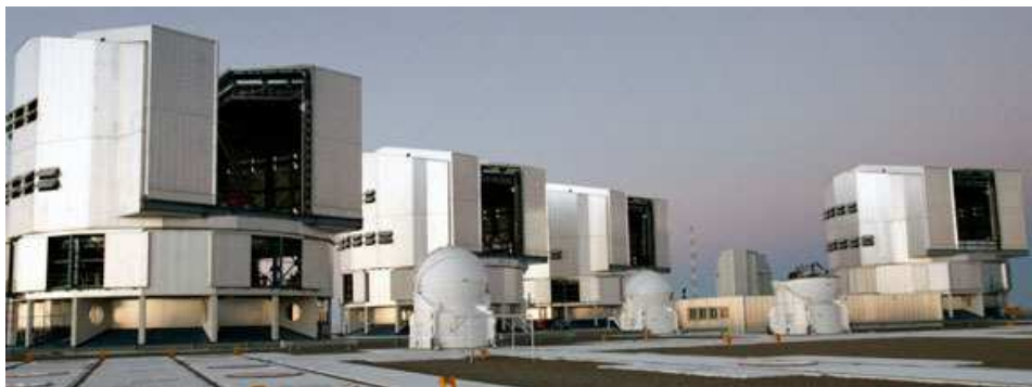
FIGURE 1.3 – L'observatoire européen VLT ( Very Large Telescope ) situé au Mont Paranal au Chili. Cet ensemble regroupe quatre des plus grands télescopes optiques. Le couplage des instruments en mode interférométrique en fait l'un des instruments les plus puissants jamais construits.
