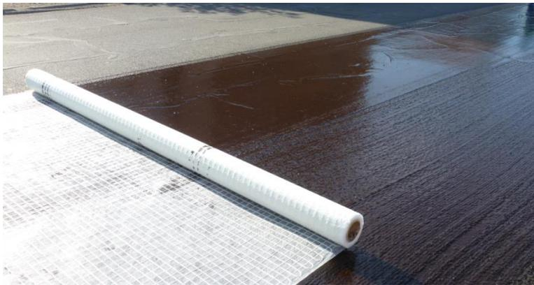
Figure 2.7 Déroulement d'un rouleau de CIDEX 100 SB et collage sur une couche d'émulsion
