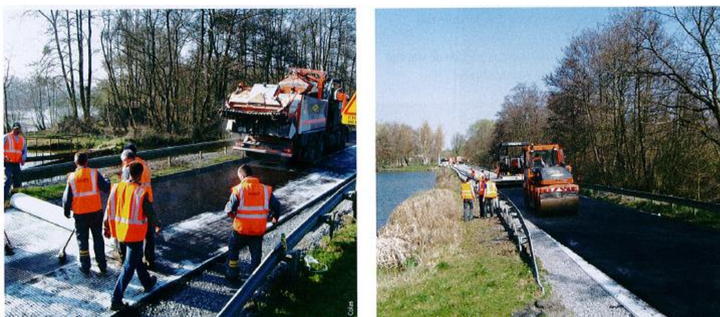
Figure 1.9 Mise en œuvre de Colgrill a. RD 624 (11) b. RD 438 à Saint-Simon (02) [RGRA n° 904, 2012]
