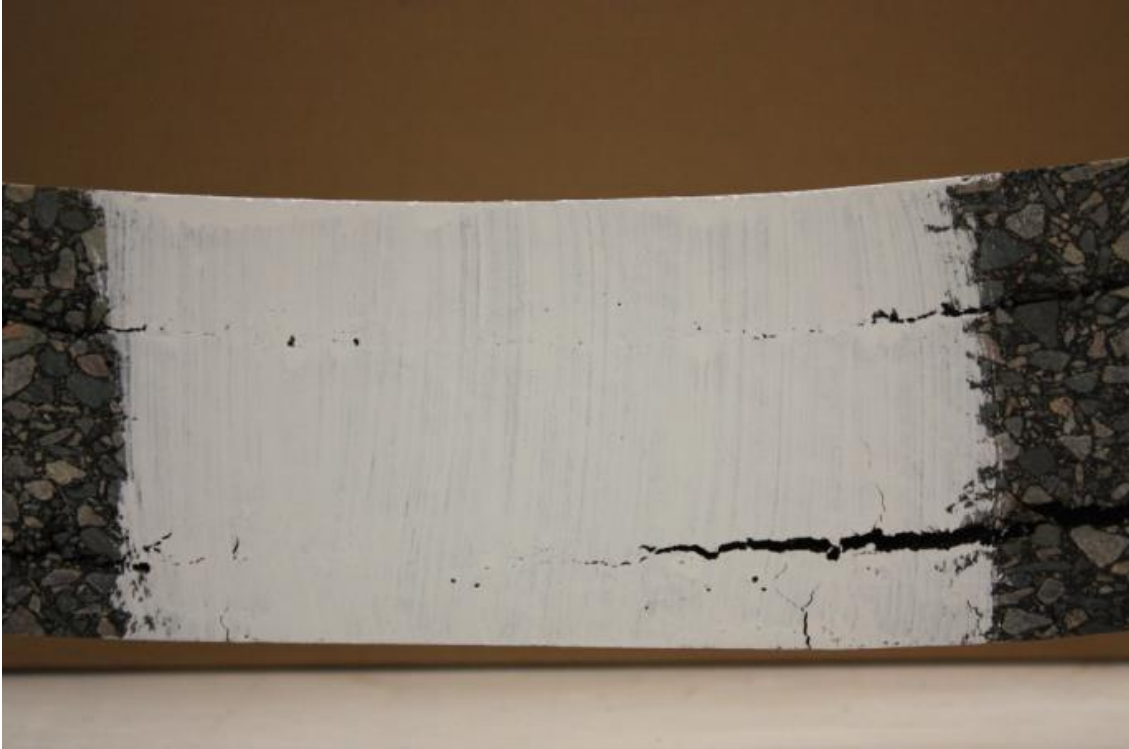
Figure i4. Etat de fissuration après 48h en flexion post-essai 4PB
