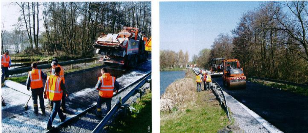
Figure 1.9 Mise en œuvre de Colgrill a. RD 624 (11) b. RD 438 à Saint-Simon (02) [RGRA n° 904, 2012]
