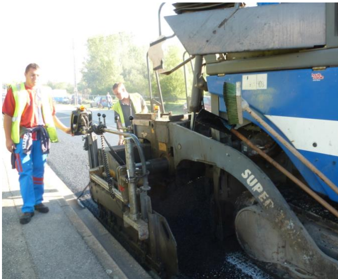
Figure a3. Passage du finisseur et réalisation de la couche de roulement en béton bitumineux
