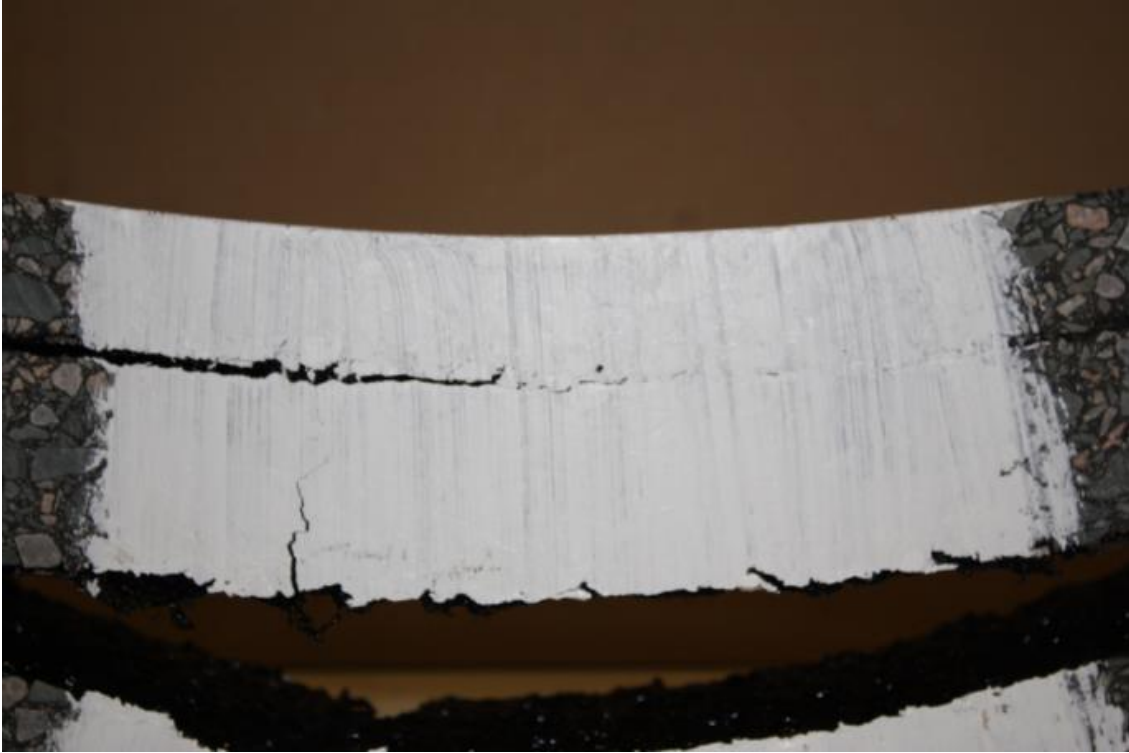
Figure i38. Etat de fissuration après 48h (2 jours) en flexion post-essai 4PB
