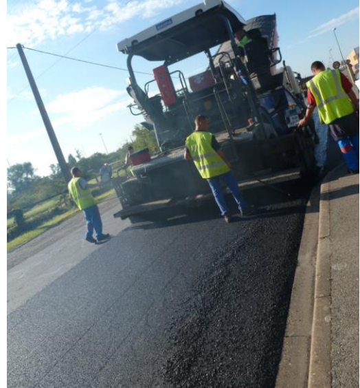
Figure a3. Passage du finisseur et réalisation de la couche de roulement en béton bitumineux
