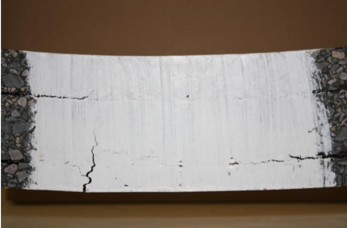
Figure i36. Etat de fissuration après 24h (1 jours) en flexion post-essai 4PB
