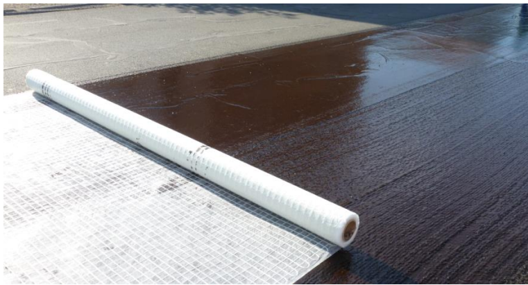
Figure 2.7 Déroulement d'un rouleau de CIDEX 100 SB et collage sur une couche d'émulsion
