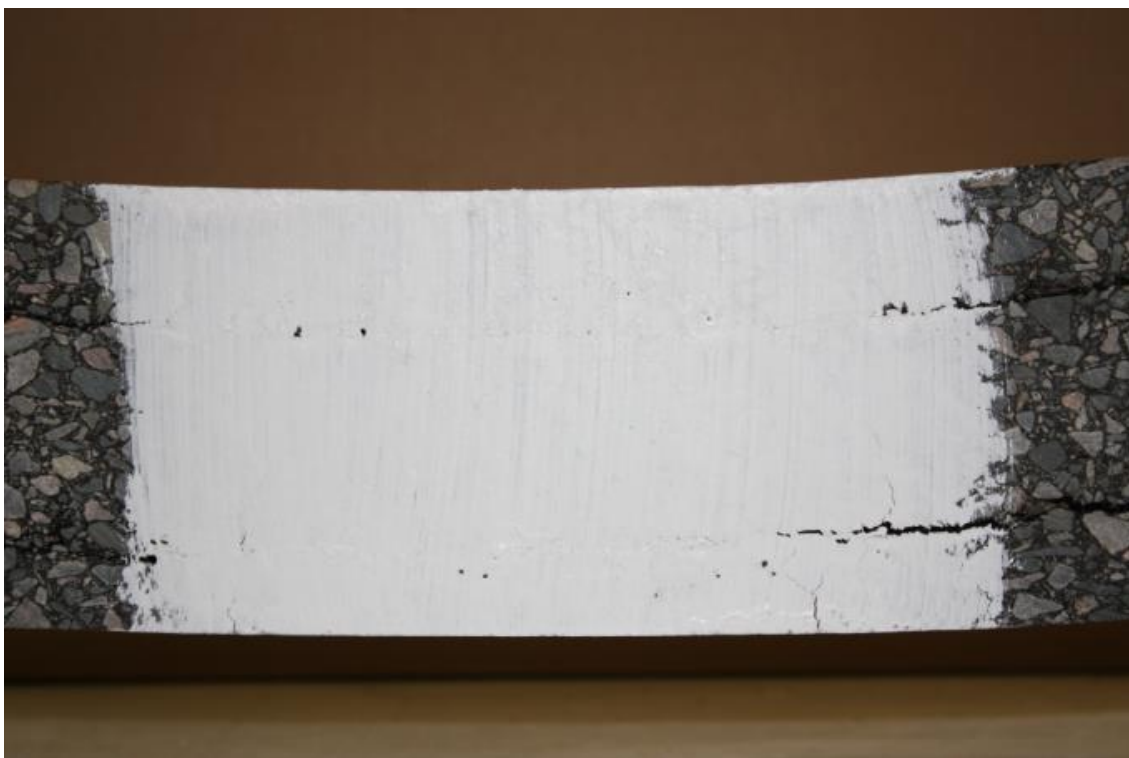
Figure 4.29 Etat de fissuration après 24 h de flexion de la poutre 20R, post-essai de fatigue à \epsilon = 115 \mu\text{m/m} . Dédoublage de la fissure macroscopique avant le niveau de l'interface et déviation au niveau de l'interface
