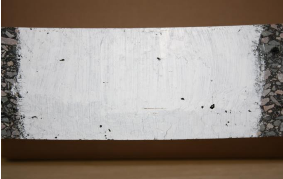
Figure i18. Etat de fissuration après 48h (2 jours) en flexion post-essai 4PB
