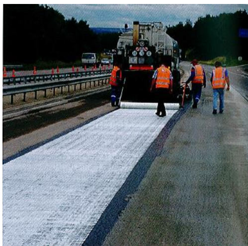
Figure 1.10. Géo-grille sur le joint voie médiane-voie rapide [RGRA, n° 845, 2006]
