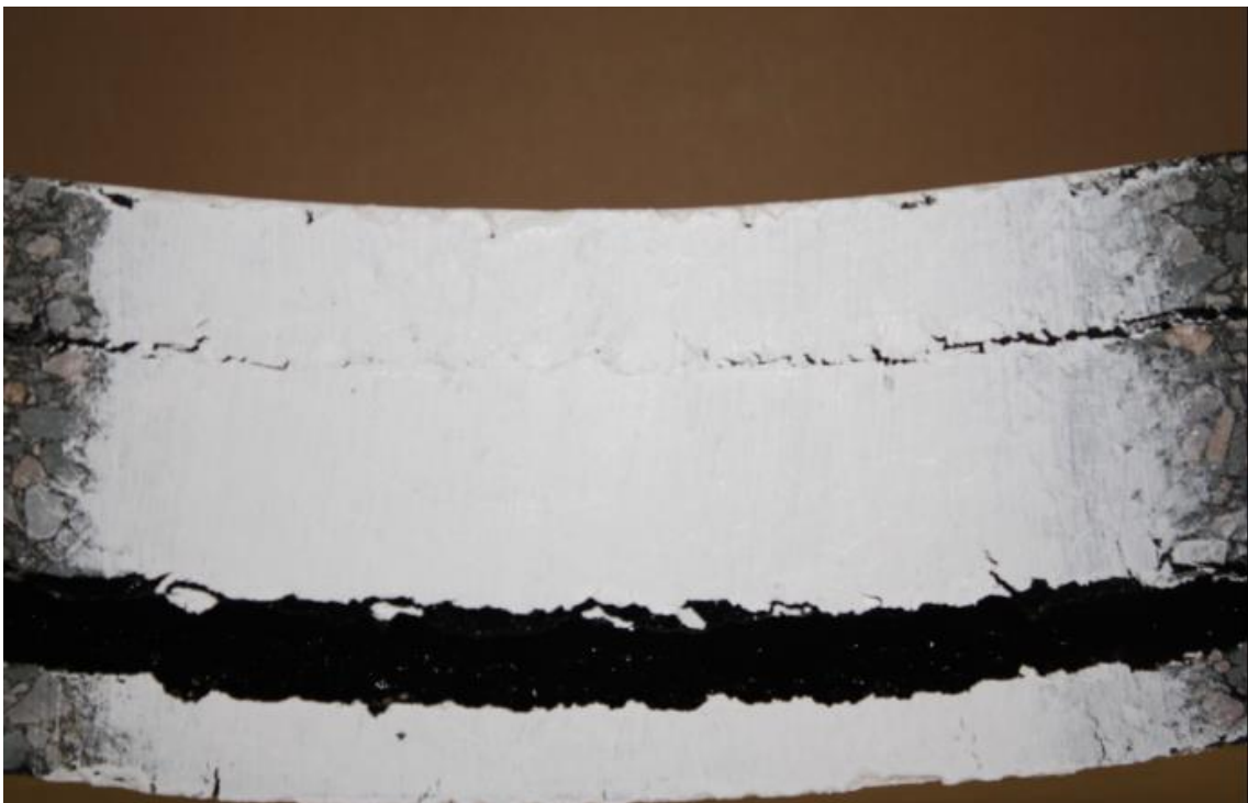
Figure i9. Etat de fissuration après 80h (3 jours + 3 h) en flexion post-essai 4PB
