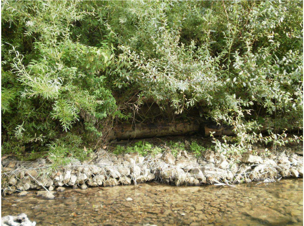
Figure 7 : Détail des techniques utilisées dans un ouvrage sur la Vernaison (gabions tubulaires, caissons végétalisés, ramilles et boutures)
