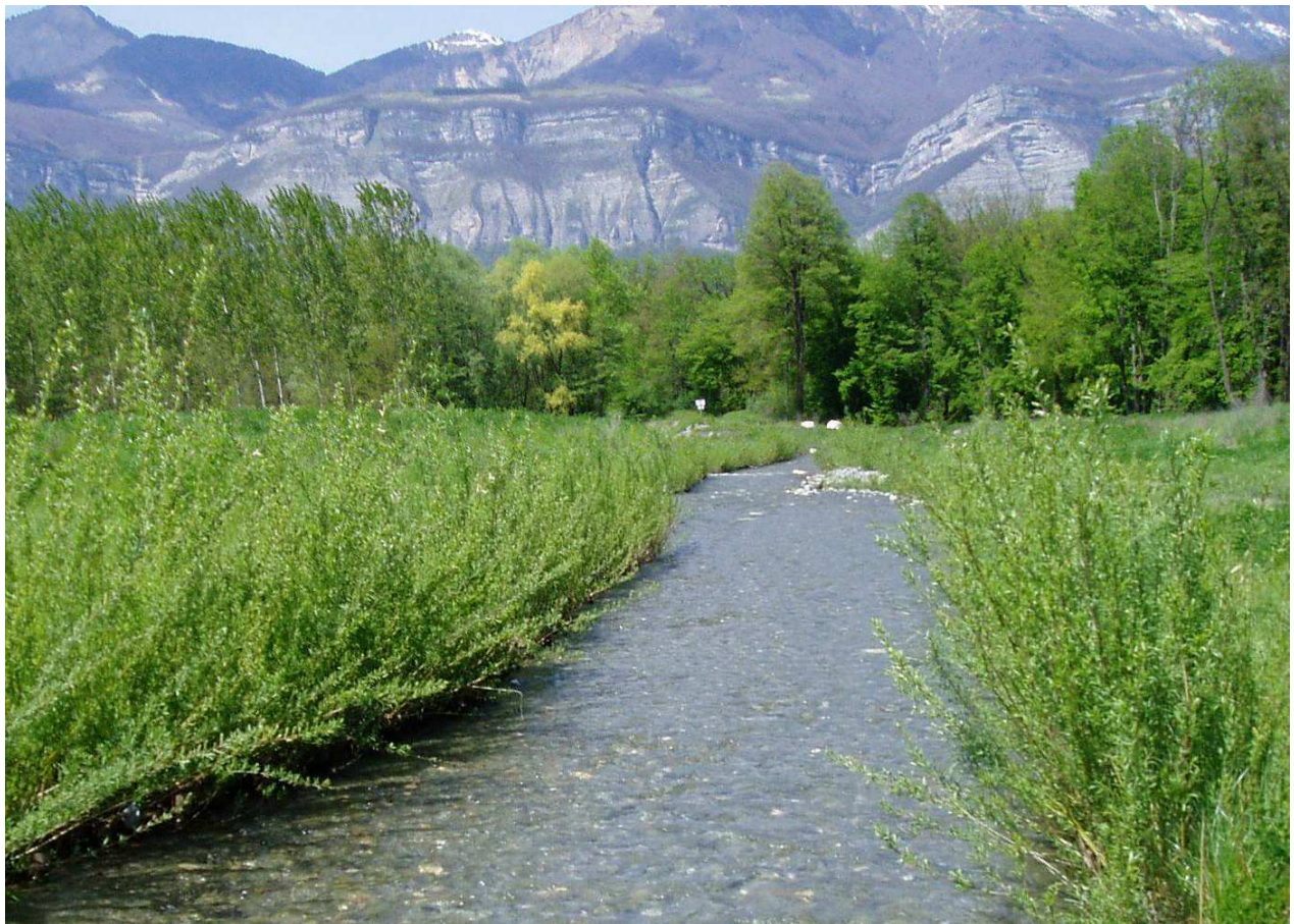
Figure 6 : Ouvrage de génie végétal âgé de deux ans sur le Vorz (cordons de fascine de saule)
