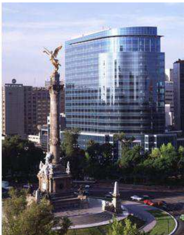
Figure 55 : Torre del Angel, achetée et rénoverée par Hines, sur le Paseo de Reforma, Mexico DF
