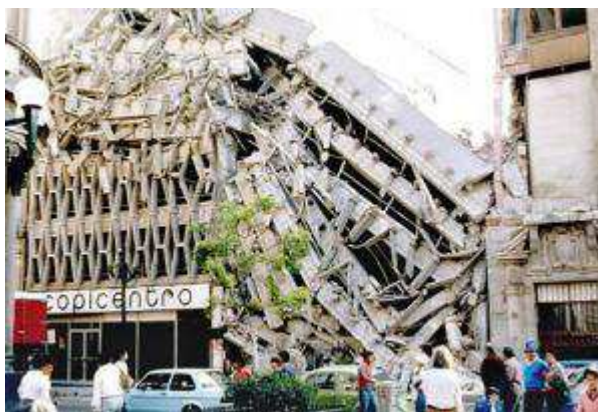
Figure 81 : Un immeuble détruit par le tremblement de terre de 1985, dans le centre historique de Mexico.
