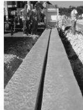
Bordures en béton extrudé
