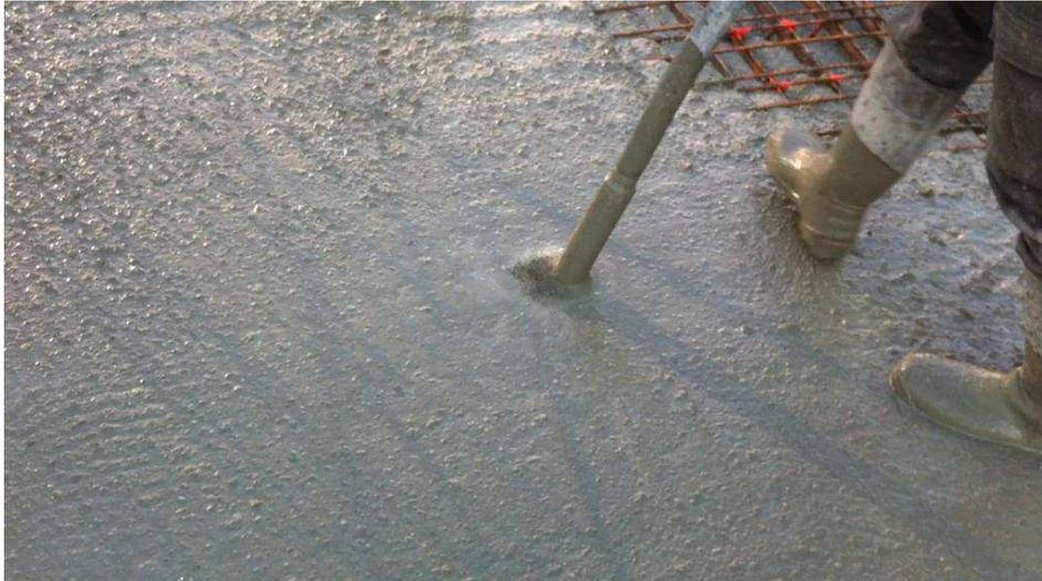
Figure 1.2. Exemple d'une vibration interne d'un élément horizontal (dalle de plancher).
