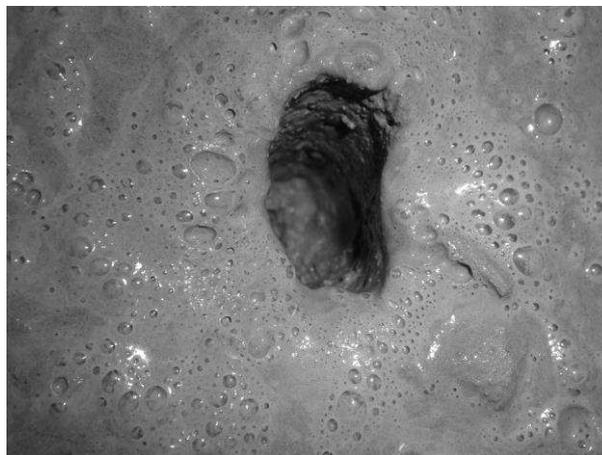
Figure 1.24. Trou non rebouché laissé après extraction d'une aiguille vibrante dans un matériau cimentaire.
