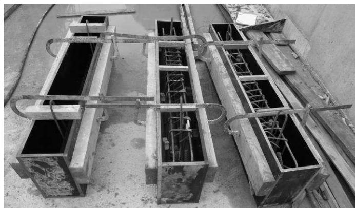
A partir de l'ensemble des essais réalisés *in situ*, nous pouvons réaliser un classement comparatif des rigidités des coffrages, s'étalant de très rigides à souples. Ce type de réalisation se situe en deuxième position.
