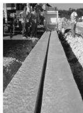
Bordures en béton extrudé
