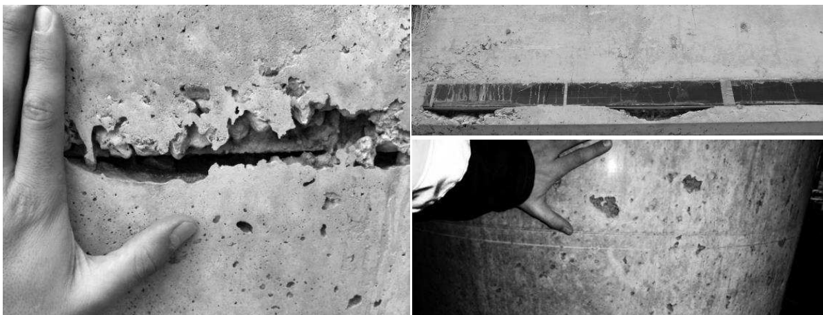
Figure 1.18. Exemples d'une sous-vibration à partir de défauts de parement.
