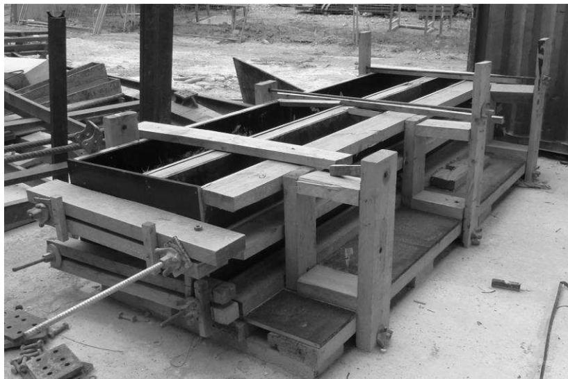
A partir de l'ensemble des essais réalisés *in situ*, nous pouvons réaliser un classement comparatif des rigidités des coffrages, s'étalant de très rigides à souples. Ce type de réalisation se situe en première position, égalité avec les coffrages réalisés sur le chantier de la Tour Majunga.
