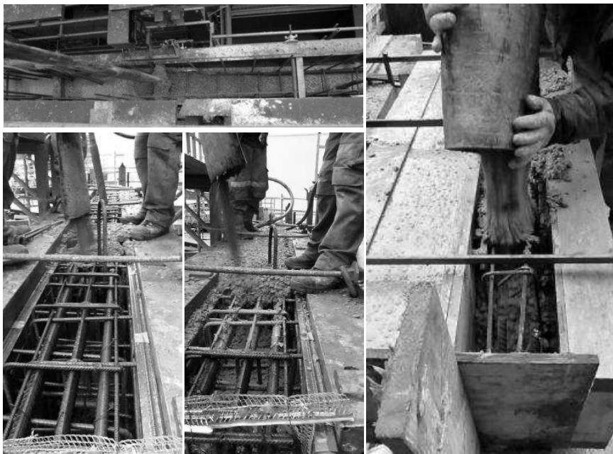
Figure 2.2. Exemples de coulages traditionnels sur un chantier de construction.
