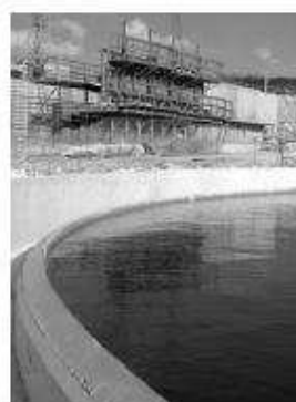
Station d'épuration - Ambonne
