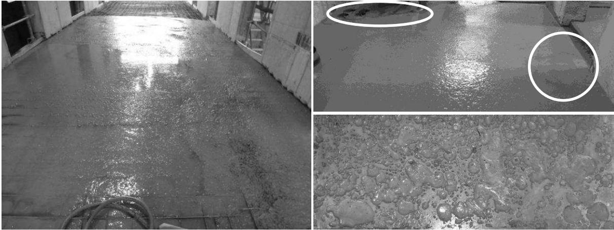
Figure 1.19. Exemples de remontées d'eau en surface.
