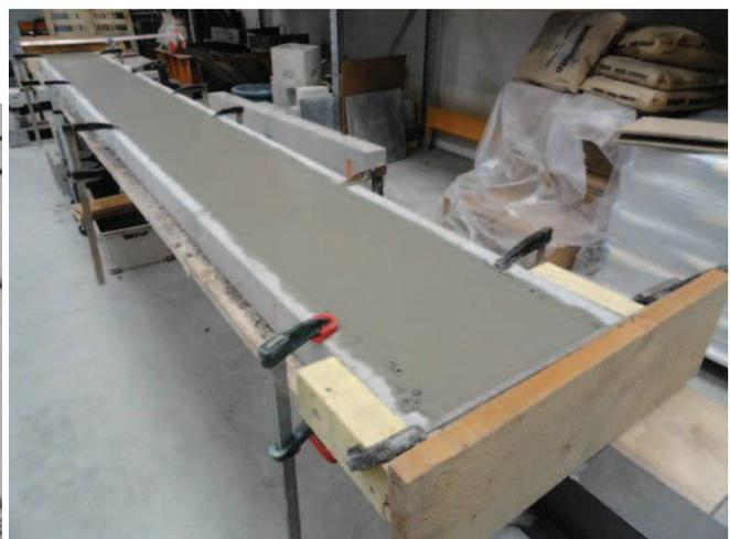
(d) Bétonnage de la dalle de compression
