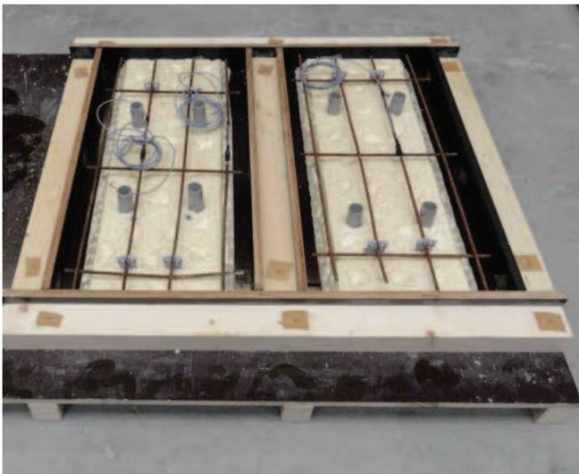
(a) Coffrages réalisés avec positionnement des armatures
