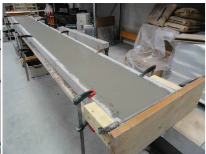
(d) Bétonnage de la dalle de compression
