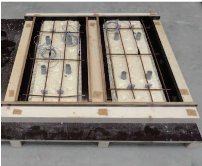
(a) Coffrages réalisés avec positionnement des armatures
