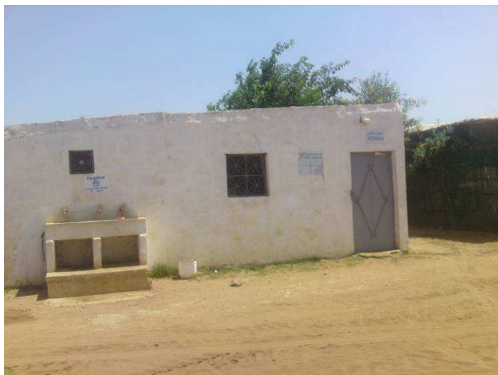
Figure 60. Local aménagé pour le stockage des produits phytosanitaires (Réalisation : Ayadi H., 2011)
