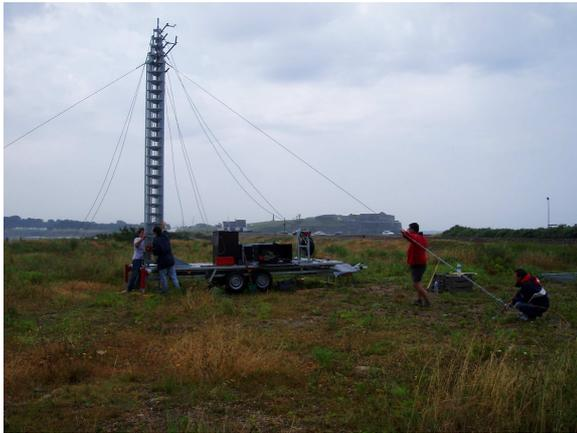
**Figure 200** Mise en position verticale du mât à PEN.
