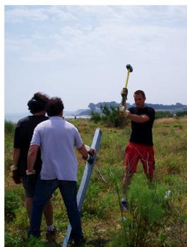
**Figure 197 Mise en place de l'ancrage des haubans (PEN).**
