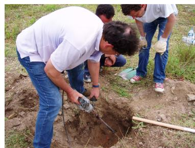
**Figure 198 Utilisation de la défonceuse pour faciliter la mise en place des pieux (PEN).**
