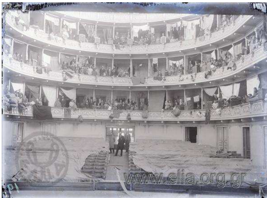
Figure 29 : Des réfugiés installés dans les loges d'un théâtre à Athènes 193
