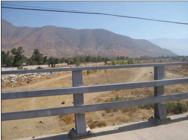
a. Le cours d'eau Lampa sec depuis 2009 n'alimente plus la zone humide à cause des prélèvements en amont par les mines artisanales et industrielles
