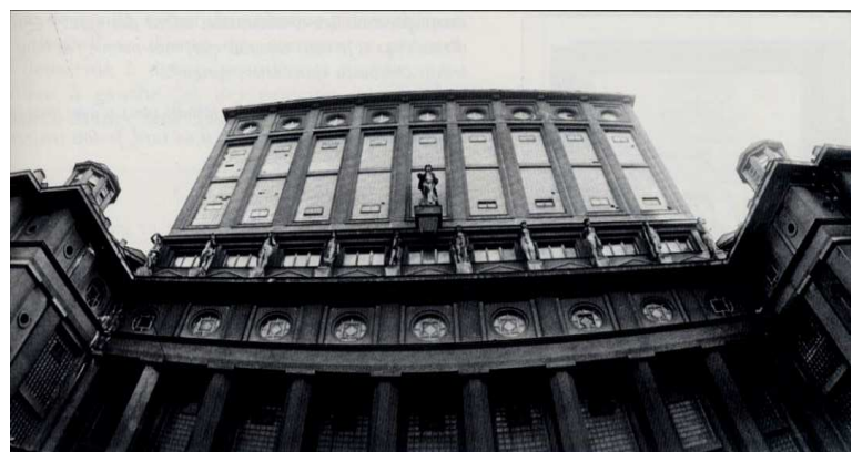
Fig. 243 Prague, p.43 Château d'eau municipale à Podoli
