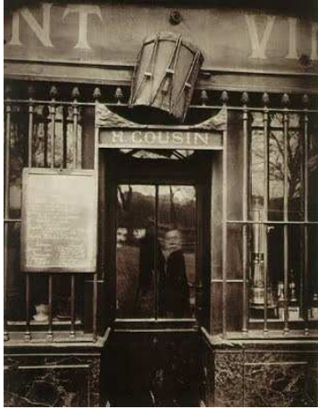
Fig. 191 Eugène ATGET Au tambour, quai de la Tournelle 1908
