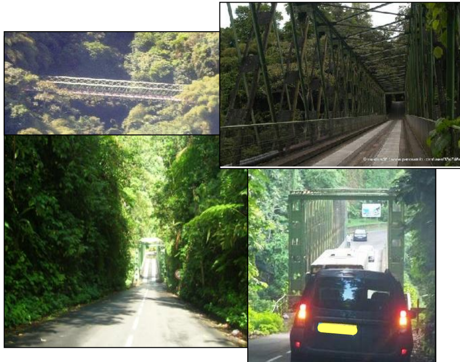
Encadré 4.1 : Le pont reliant les habitants de Grand-Rivière au reste de la Martinique : un point de vulnérabilité et de blocage potentiel en cas de crise (Mas, 2007 ; Google Earth, Images)
