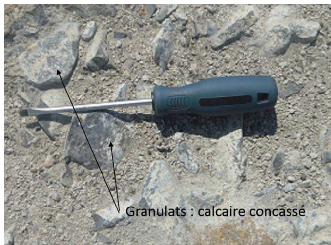
Figure 3-3 : Béton de masse de l'écluse de Saint-Lambert (juillet 2013)
