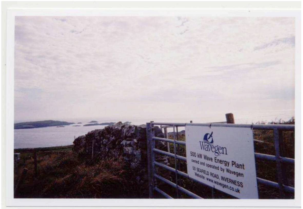
Figure 1 : Entrée du site de la Centrale LIMPET (Source D.Guérin)
