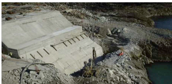
Figure 11 : Centrale LIMPET avant démolition de la falaise (source : Wavegen, 2000)
