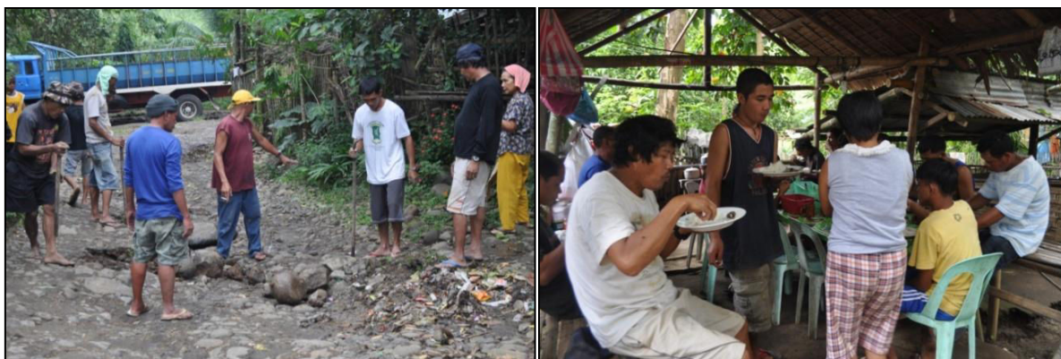
Figure 103 : Travail collectif pour réparer la route de terre du village de Yubo (gauche). Un repas a été préparé par les femmes après le travail dans la maison du chef de village de Yubo (droite) (J. Cadag, décembre 2011).
