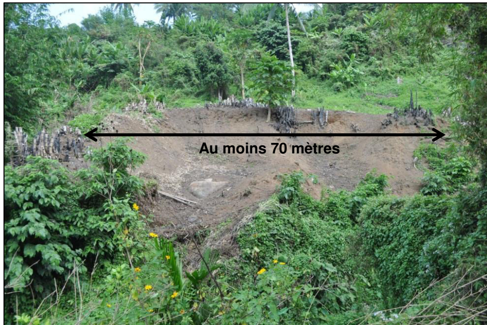
Figure 77 : Un petit glissement de terrain rotationnel en 2009 à Yubo d'une superficie d'au moins 1500 mètres carrés (J. Cadag, décembre 2011)
