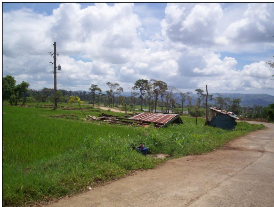
Figure 83 : Une maison détruite par un typhon en 2009 dans le village de Masulog (NIRD, 2009)
