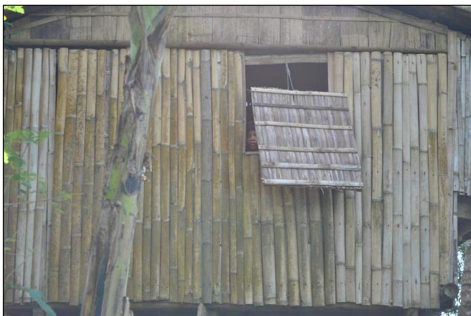
Figure 107 : Les murs en bambou présentant une technique avancée de couture (J. Cadag, décembre 2011)
