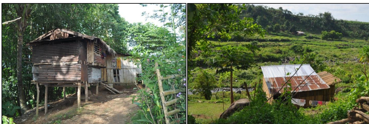
Figure 87 : Les maisons isolées des Cebuanos à Yubo (territoire Ilonggo) situés sur les flancs de coteau (gauche) et des berges (droite) (J. Cadag, décembre 2010)
