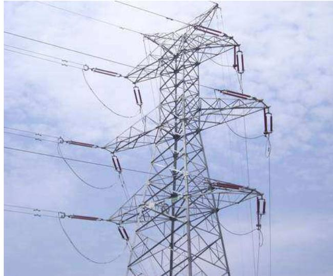
Figure 1. 1. Isolateurs composites sur une ligne électrique 220 kV
