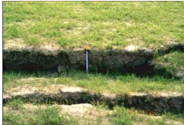
FIGURE A.9: Fissures considérables dans le sol à Nantou
