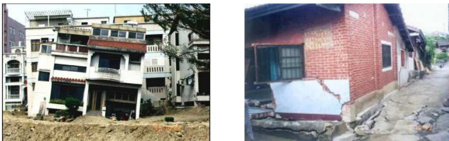
FIGURE A.7: Endommagement de bâtisses dû à la liquéfaction en Taiwan
