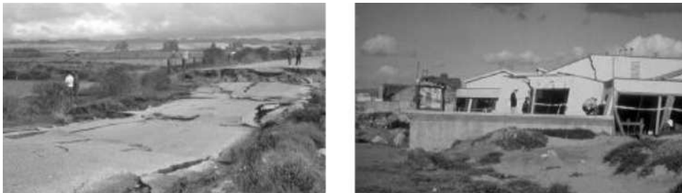
FIGURE A.2: Epandage latéral le long de la route Sandholdt (à gauche) et destruction d'un centre de recherche (à droite) à Moss Landing. (d'après Khaled (2012))
