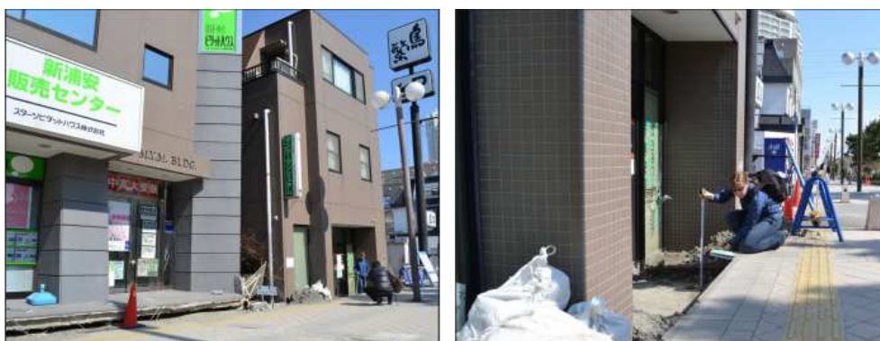
FIGURE 1.4.5: Poinçonnement de la fondation sous l'effet de la liquéfaction sismique Tohoku 2011
