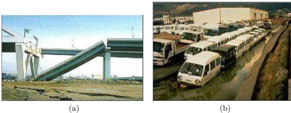
FIGURE A.5: a) Endommagement des ponts : Un tel dommage peut avoir des conséquences désastreuses, empêchant même les opérations de sauvetage. Les mouvements induits par la liquéfaction peuvent pousser les bases hors du point où le pont enjambe l'appui, dans ce cas le pont lâche (d'après Khaled (2012)) ; b) Endommagement des routes : Baisse du niveau de la route due à l'épandage latéral
