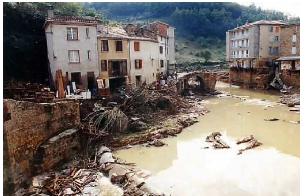
Fig. 0.1 – Destructons suite à une crue-éclair de la Salz à Rennes-les-Bains (Aude) le 26 septembre 1992.
