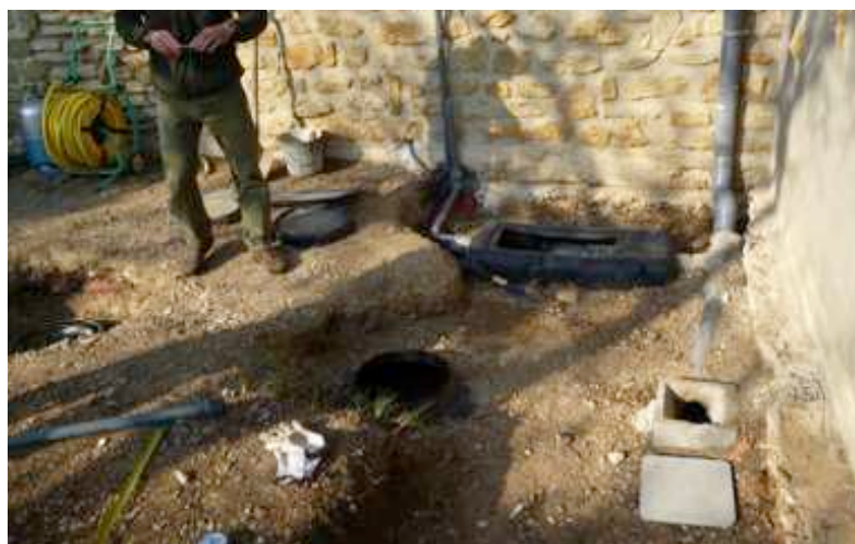
Illustration 4 : Photographie d'un contrôle d'une installations existante : découverte de l'installation (Vaucluse) Source : ROLLIN J., 2012.
