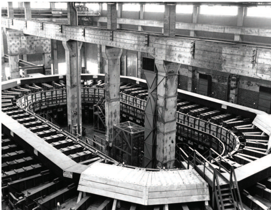
Figure I-2 : Calutron du site de Oak Ridge – Tennessee, USA – utilisé lors du projet Manhattan pour enrichir l'uranium destiné à la bombe A (d'après le United States Department of Energy)
