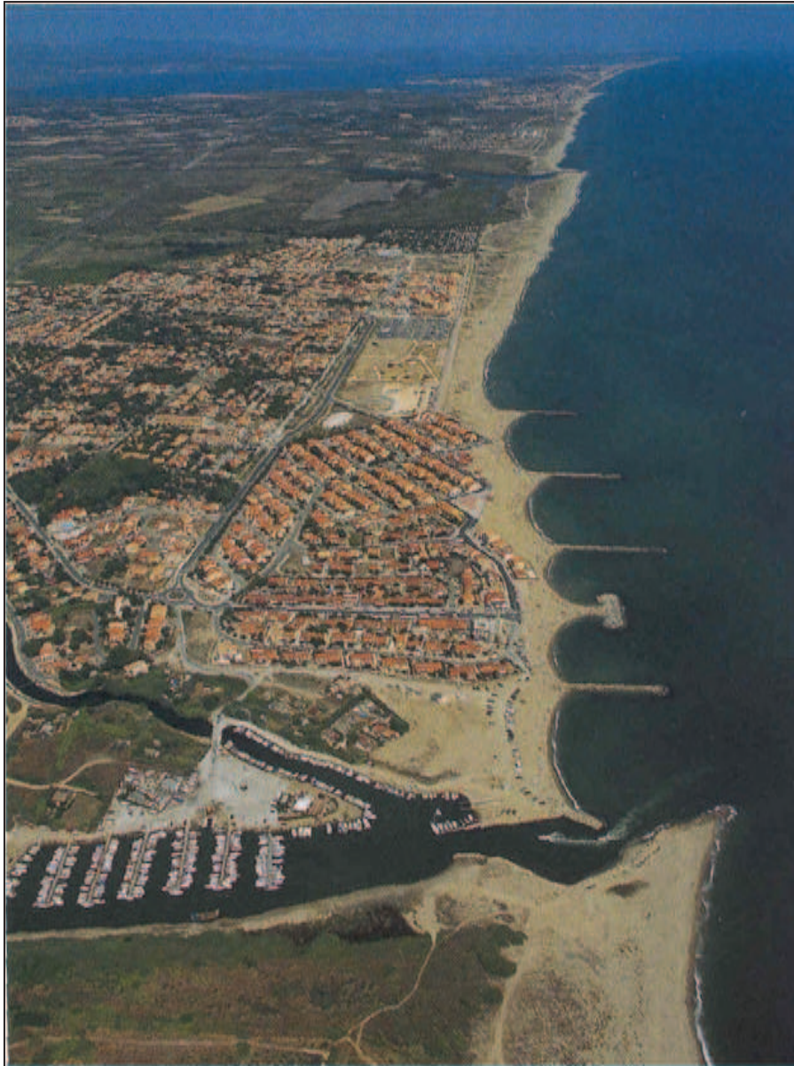
Fig. 1.9 : Photographie aérienne oblique de Sainte Marie Plage et ses ouvrages de défense contre la mer (DREAL-LR). Le blocage des sédiments en amont du port (bas de la photo) a engendré une forte érosion stabilisée par les ouvrages de défense. Cette érosion s'est décalée en aval transit (haut de la photo).
