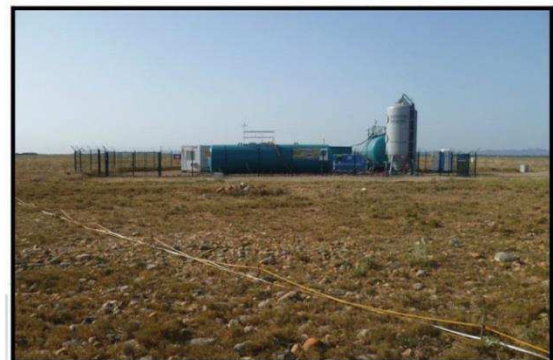
SITE ET USINE DE TRAITEMENT DES EAUX POLLUEES (2012)
