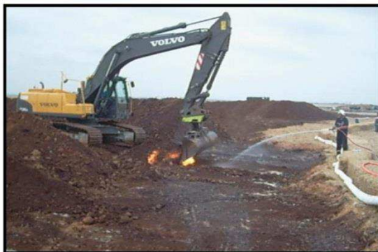
EXCAVATION DES PREMIERS DECIMETRES DE SOL IMPACTE (2009)
