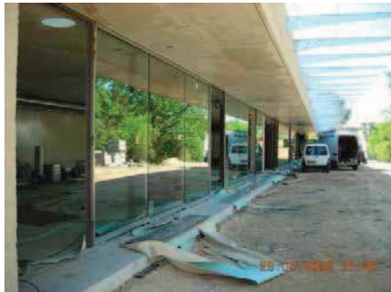
Pose des vitrages, Avril 2008
