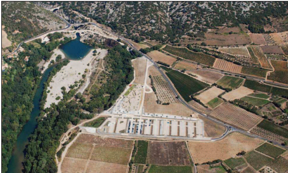
Fig. 4.14 – Photographie aérienne du Pont du Diable et de ses abords, où l'on observe le projet d'aménagement mis en place. Source : CERPA, C. Renard et A. Humbert, août 2010.
