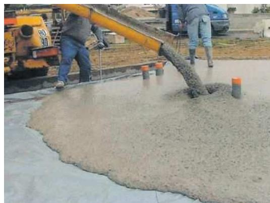
**Figure 1.1 Coulage d'une dalle en béton autoplaçant**
