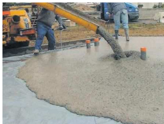
Figure 1.1 Coulage d'une dalle en béton autoplaçant
