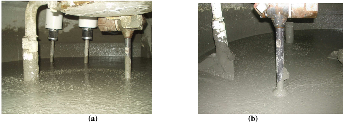
Figure 4.2 Remplissage du béton dans le malaxeur : 1000 L (a) et 600 L (b)
